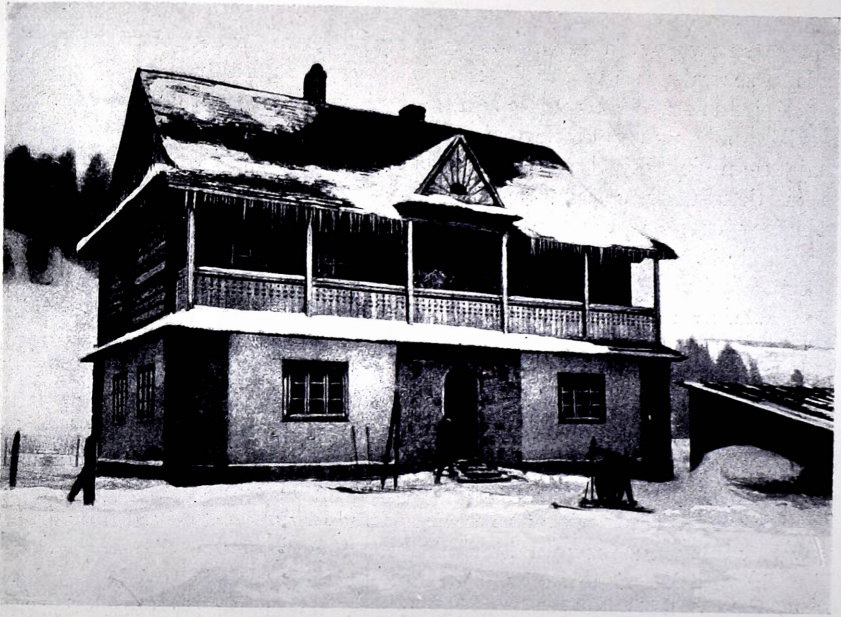
Nowo odbudowane schronisko K. T. N. w Sławsku.
