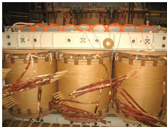
Rys. 5.20. Ogólny widok światłowodów po instalacji w uzwojeniach transformatora 6MVA [Oprac. własne]
