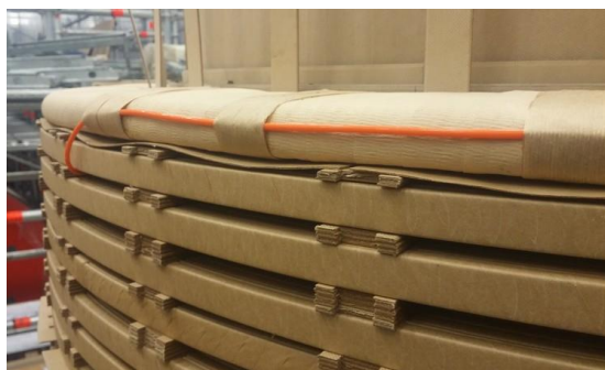
Rys. 7.10. Widok mocowania przewodu światłowodowego C05 uzwojenia GN [Oprac. własne]
