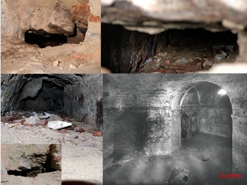
Fot. 14.2. Rotunda św. Prokopa, kanały od centralnego ogrzewania, wejście do podziemi świątyni Photo 14.2. The Rotunda of St. Prokop, central heating ducts, entrance to the church basement
