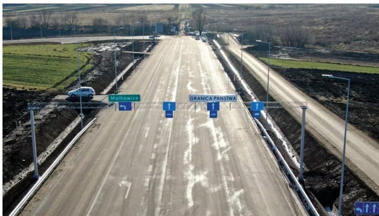
Fot. 18.3. Zakończona w grudniu 2020 roku przebudowa drogi nr 885 (Przemysł–Malhowice)*
