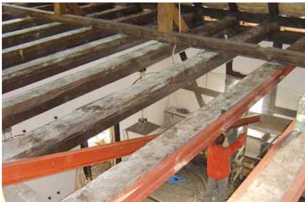
Przebudowa z lat 2007-2008 – wzmacnianie stropów w budynku głównym
