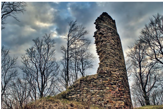
4. Ruiny wieży z przełomu XIII/XIV wieku od strony północno-zachodniej. Widok obecny. Fot. C. Czerniachowicz
