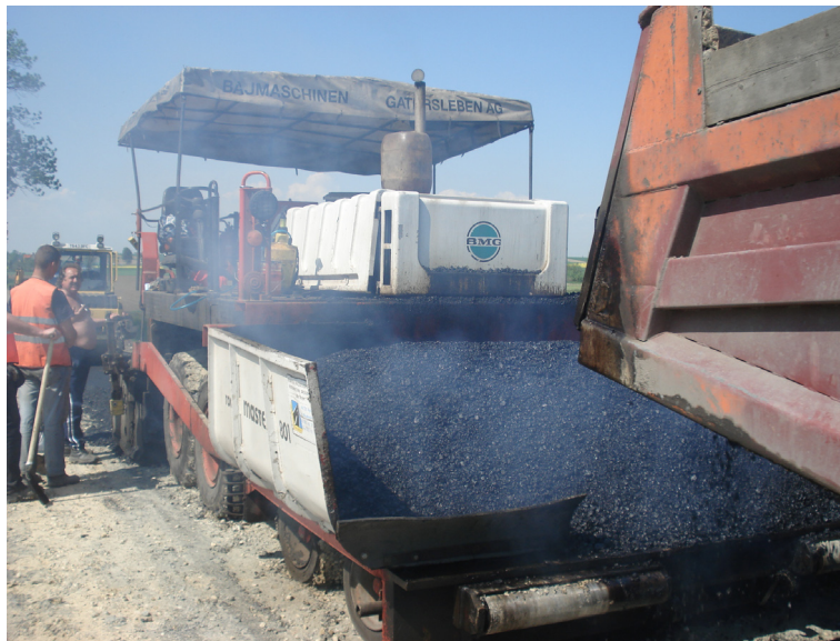
Rys. 1.16. Załadunek MMA do kosza rozkładarki
