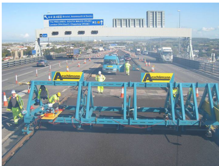
Rys. 3.7. Wykonywanie nawierzchni z asfaltu lanego
