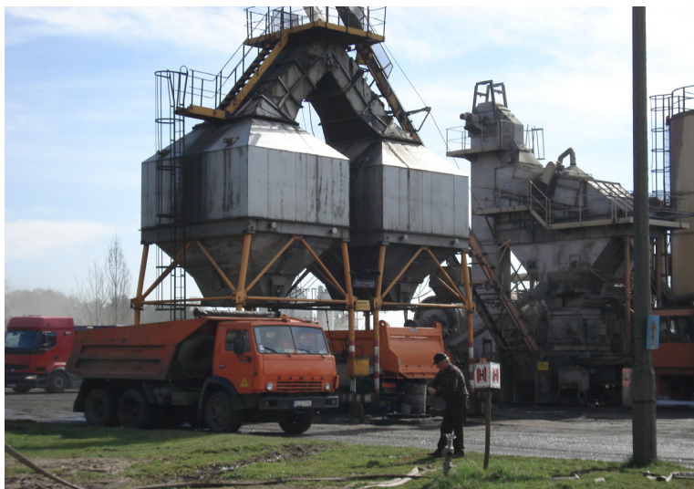
Rys. 1.5. Zasobniki gorącej mieszanki mineralno-asfaltowej – tzw. silosy
