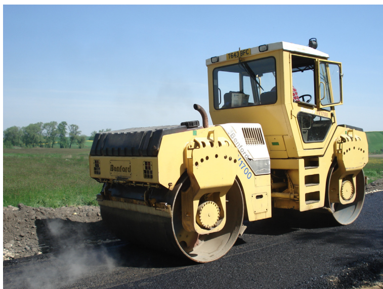
Rys. 1.18. Zagęszczanie warstwy podbudowy bitumicznej przy użyciu walca stalowego
