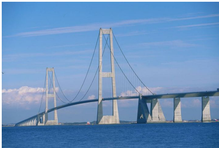
Rys. 3.6. Most wiszący przez Wielki Biełt w Danii, gdzie zastosowano jako nawierzchnię specjalistyczny asfalt lany
