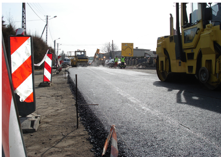
Rys. 1.7. Zagęszczanie mieszanki bitumicznej przy zastosowaniu walców stalowych
