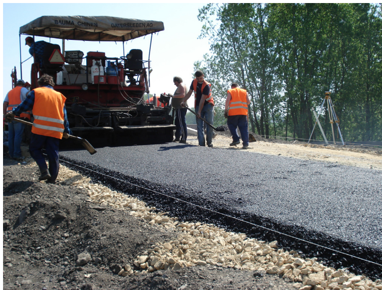
Rys. 1.17. Układanie MMA przy użyciu rozkładarki
