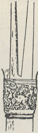
Nordostsäule (alte Chorsäule) in Bang mit Eisene über dem Kapitäl.
