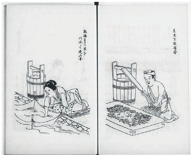
31. Ubijanie włókien i ich płukanie 31. 靱皮繊維を叩いて解してから洗います 31. Fibre beating and rinsing
