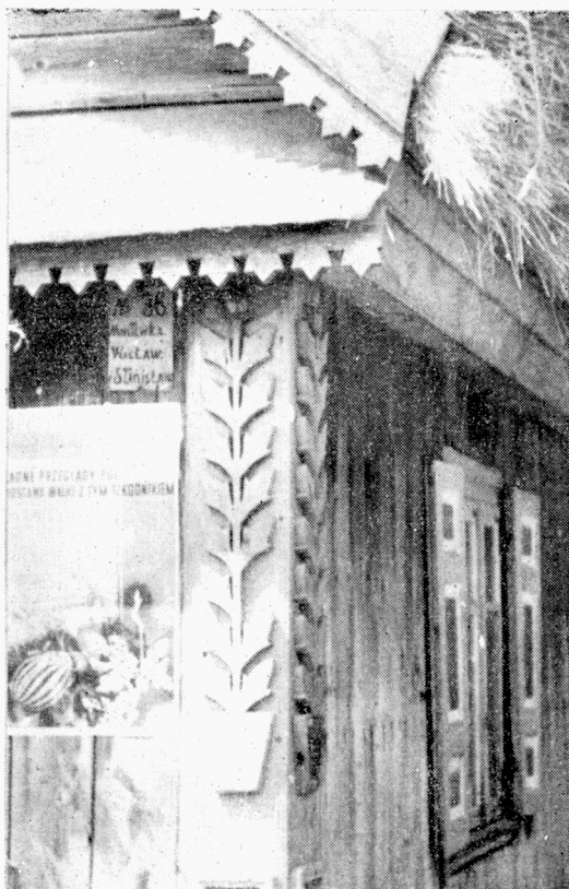
Ryc. 8. Narożnik domu „kożuchowanego“. Wola Suchożebrska, pow. Siedlce. Fot. R. Reinfuss.
