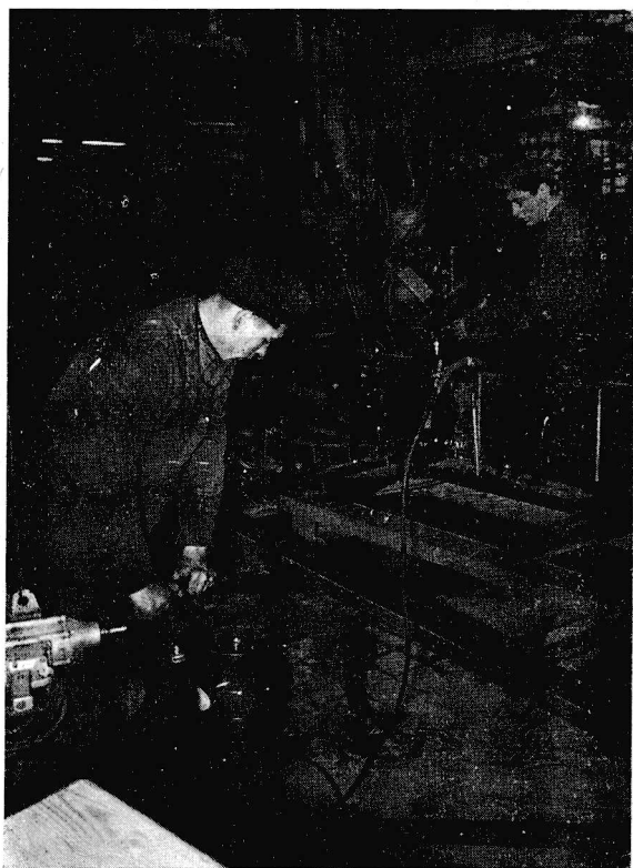
Rys. 3. Odpowietrzanie hamulców
