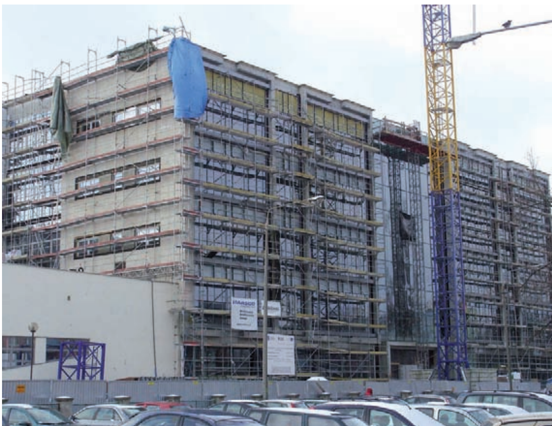
Budynek DCNIE (grudzień 2010)
