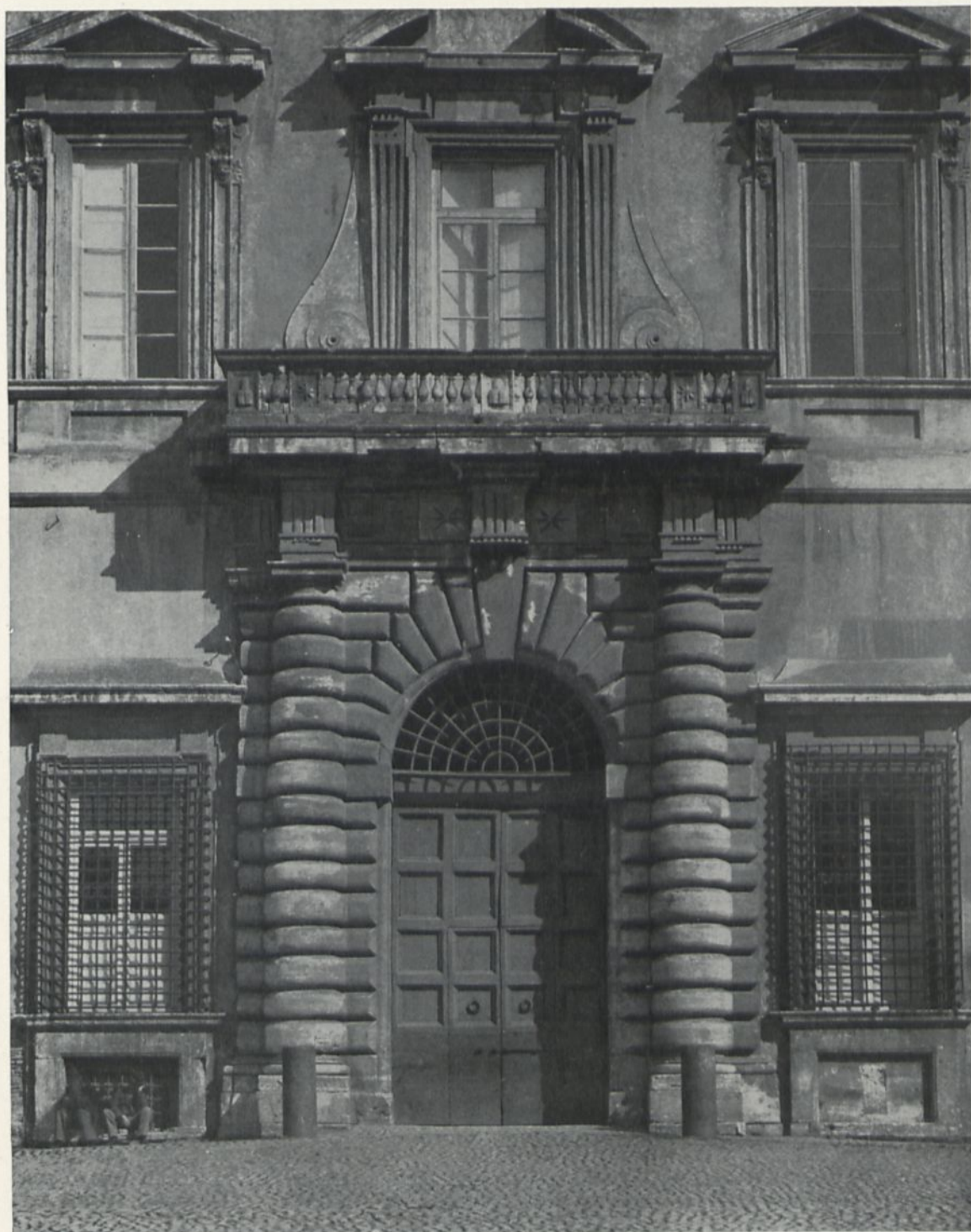
Rom. Lateranpalast von Domenico Fontana (1587). Portal
