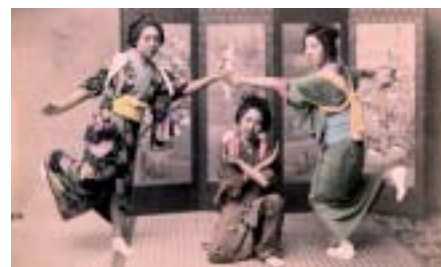
Kusakabe Kimbei, TAŃCZĄCE, ok 1890
