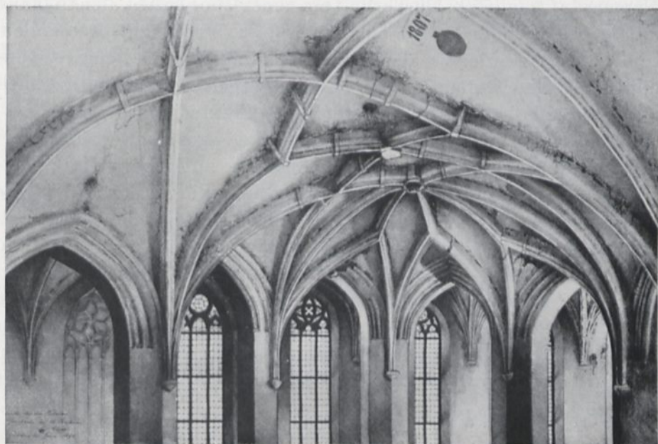
72 NETZGEWOLBE DER ST. JAKOBSKIRCHE IN NEISSE VOR DEM ABBRUCH 1891
