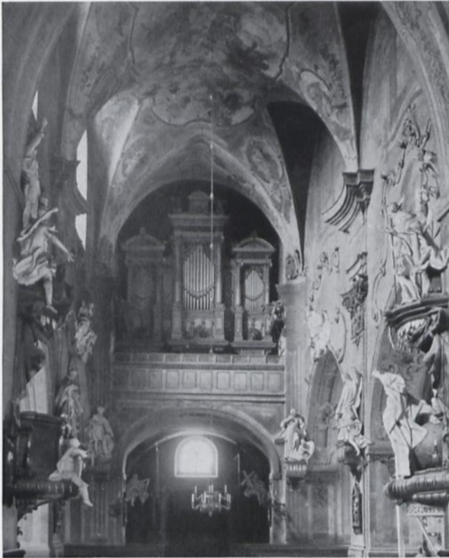
150 OBERGLOGAU · KATHOLISCHE PFARRKIRCHE, ORGELCHOR VOR DEM UMBAU
