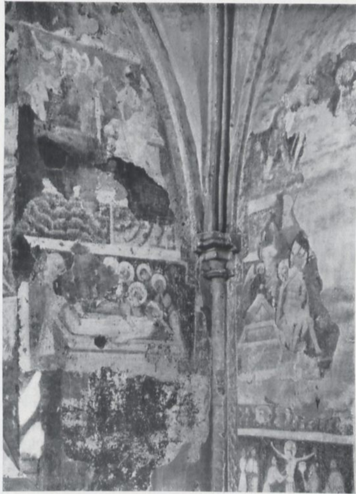
103 KALKAU, OST- UND SÜDWAND WÄHREND DER AUFDECKUNG
