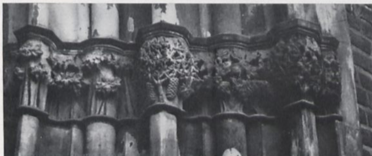
54 LEOBSCHÜTZ, KAPITELL AM SÜDPORTAL DER KATHOLISCHEN PFARRKIRCHE
