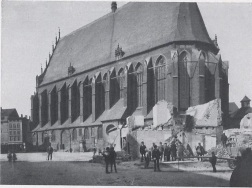
61 ST. JAKOBUSKIRCHE 1888, IM VORDERGRUND ABRUCH DER ALTARISTENHAUSER
