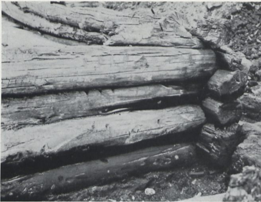
88 ECKE EINES HOLZHAUSES VON OPPELN MIT KERBMARKEN AN DEN ÜBEREINANDERLIEGENDEN BALKEN
