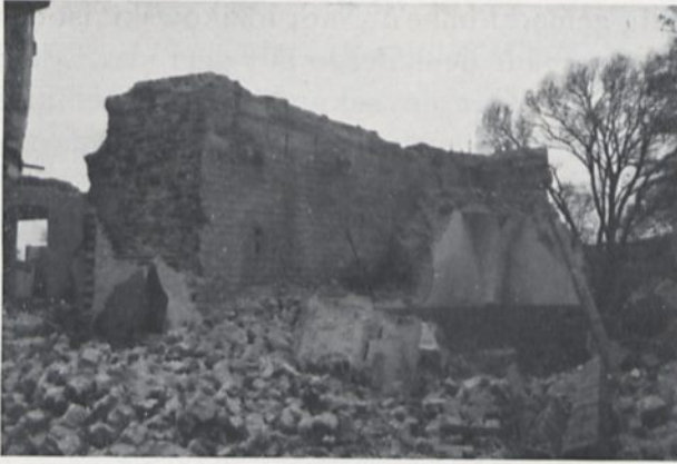
73 FREIGELEGTER TEIL DER BURGMAUER VON 1228 VOR DEM SCHLOSSTURM
