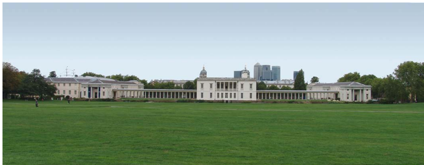
II. A.21. Widok na Queen House w Greenwich w Londynie. W tle wysoka zabudowa doków londyńskich. Źródło: fot. autorki
