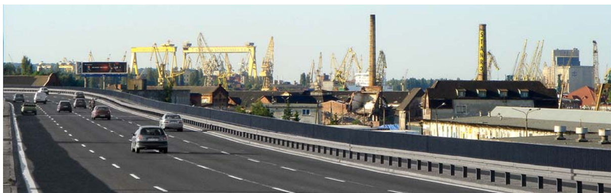
Il. 3.12. Widok z Trasy Zamkowej na obszar Stoczni Szczecińskiej z charakterystycznymi, żółtymi dźwigami i suwnicami, które stanowią istotny element krajobrazu kulturowego miasta. Źródło: fot. autorki
