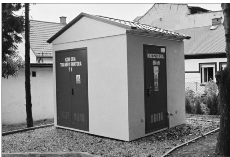
Rysunek 5.12. Kontenerowa stacja transformatorowa w obudowie betonowej typu MRw-b1 20/630 (producent: ZPUE Włoszczowa S.A.) [48]
