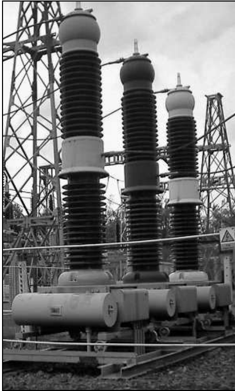
Rysunek 2.2. Wyłącznik małoolejowy na napięcie 110 kV
