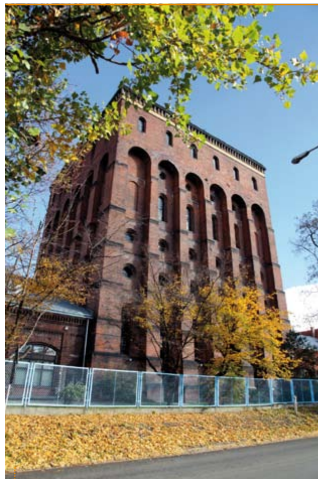
Wieża ciśnień z 2. połowy XIX w.
