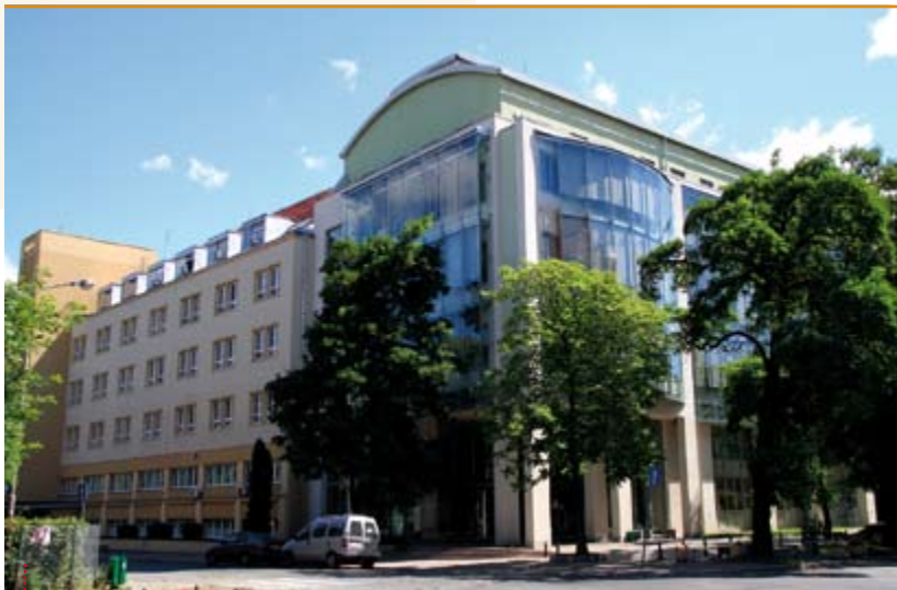
Budynek Wydziału Mechanicznego PWr (B-4) przy ul. Łukasiewicza
