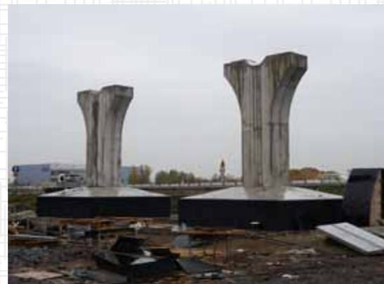
widok na filar wiaduktu WD1
