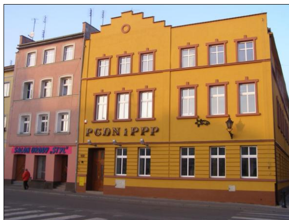
Budynek PCDN i PPP po remoncie elewacji, grudzień 2006
