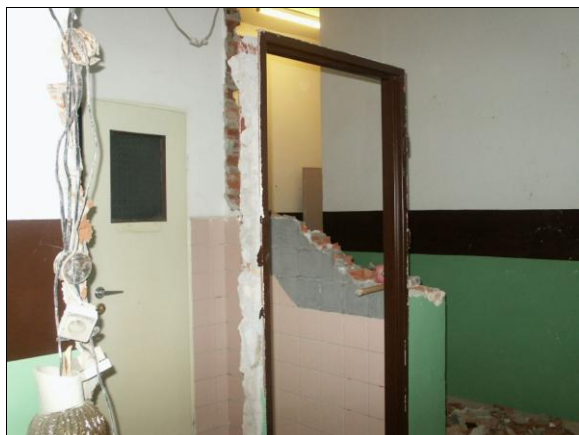
Remont korytarza na parterze, listopad 2002
