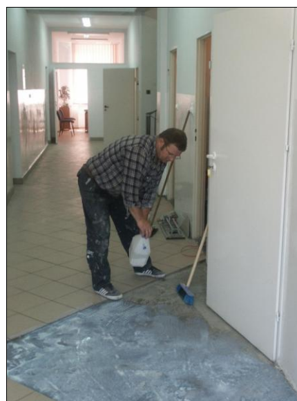
Remont korytarza na I piętrze, wrzesień 2002
