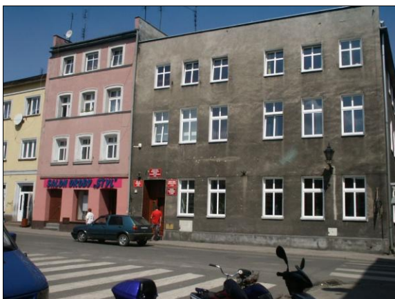
Budynek PCDN i PPP przed remontem elewacji, maj 2006
