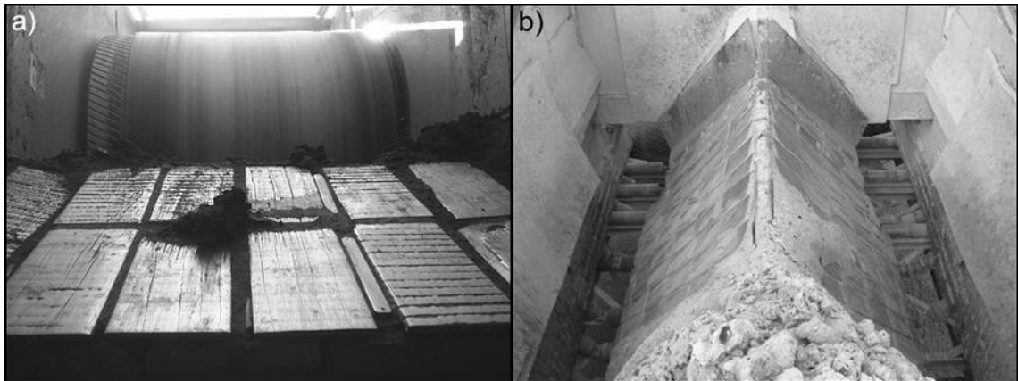
Rys. 156. Wybrane elementy konstrukcyjne koparki KWK-1500s (K9): a) przesyp TN 1.2 w przesypie przenośnika odprowadzającego nadkład na zwałowisko zewnętrzne, b) rozdzielnia nadkładu TN 1.6 z tzw. daszkiem wykonanym z płyt wykładzinowych ze stali 18G2A (P355N) bez napoiny
