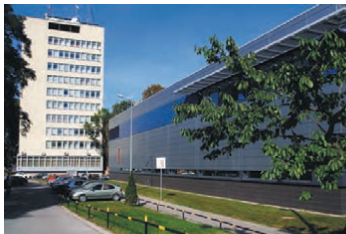
Budynki C-15 i C-5 – wrzesień 2011 r. (fot. R. Bocheński)
