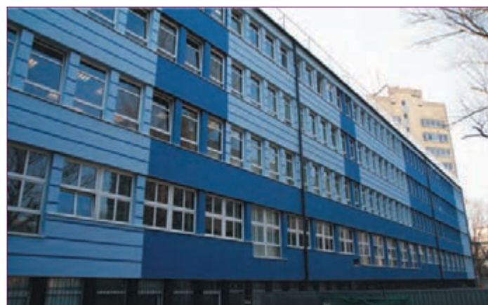
Elewacja północna budynku C-3/C-4 (fot. R. Bocheński)
