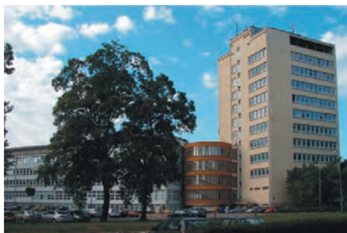
Budynki C-5 i C-4–2008 r. (fot. R. Bocheński)
