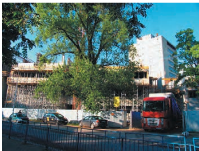
„Technopolis” w budowie – wrzesień 2011 r. (fot. R. Bocheński)
