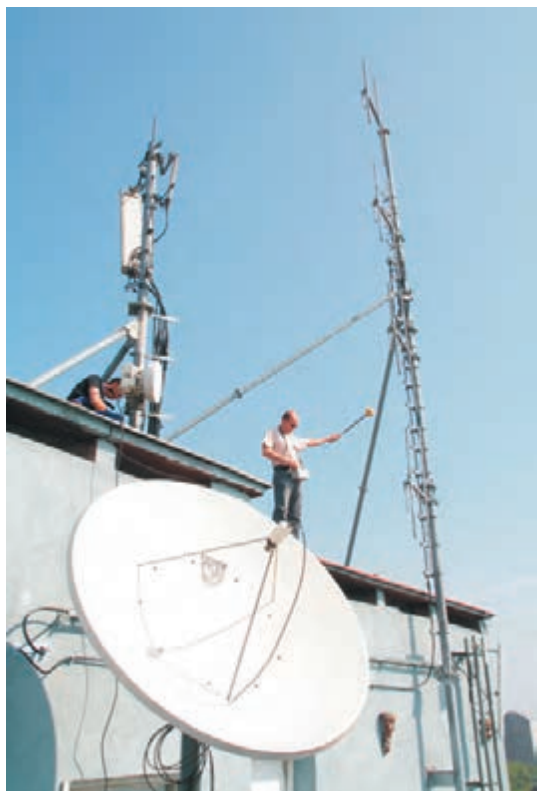
Pomiary natężenia pola elektromagnetycznego w otoczeniu anten nadawczych – P. Bieńkowski (fot. K. Mazur)
