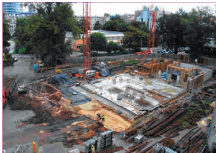
Początki budowy Centrum „Technopolis” (wrzesień 2010r.) (fot. R. Bocheński)
