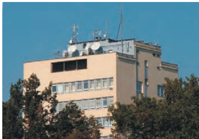
„Ogródek” anten satelitarnych na dachu budynku C-5 Instytutu Telekomunikacji, Teleinformatyki i Akustyki
