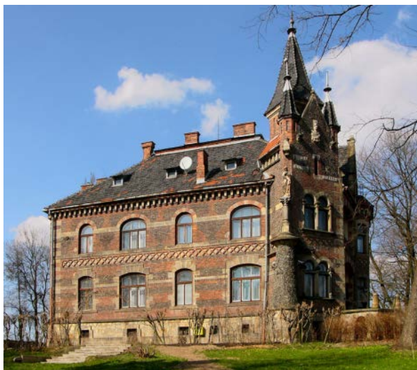
Ryc. 63. Dwór w Grodkowicach, elewacja południowa /fot. autora, 2011/
