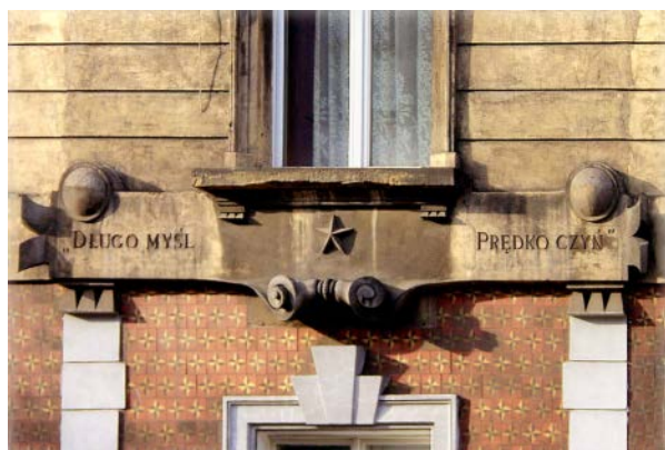
Ryc. 72. Fragment elewacji domu przy ul. Retoryka 15 /fot. autora, 2008/
