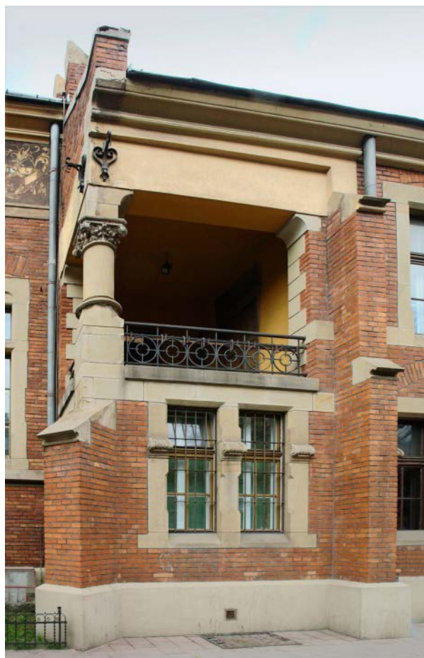
Ryc. 85. Podcień narożny rozbudowanego przez Talowskiego budynku Sokoła w Krakowie /fot. autora, 2009/
