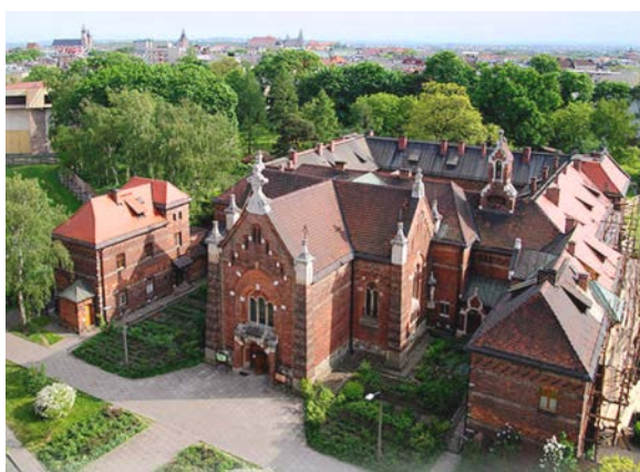
Ryc. 137. Klasztor Karmelitanek Bosych przy ul. Łobzowskiej 40 – arch. F. Mączyński (1905) Fig. 137. Barefoot Carmelites Convent on Łobzowska St. No.40 arch. F. Mączyński (1905)
