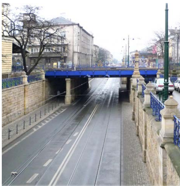
Ryc. 50. Podkop i wiadukt kolejowy – ulica Lubicz w Krakowie /fot. autora, 2008/
