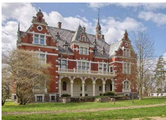
Ryc. 125. Pałac w Zakrzewie (1886) – elewacja ogrodowa z podcieniem
