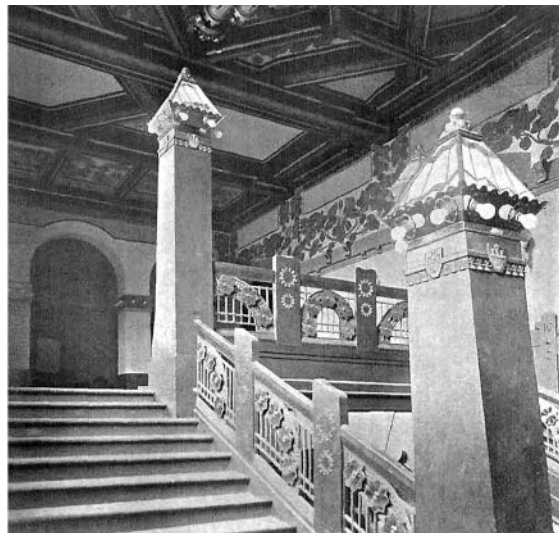
Ryc. 15. Teatr Stary po przebudowie – główna klatka schodowa.
