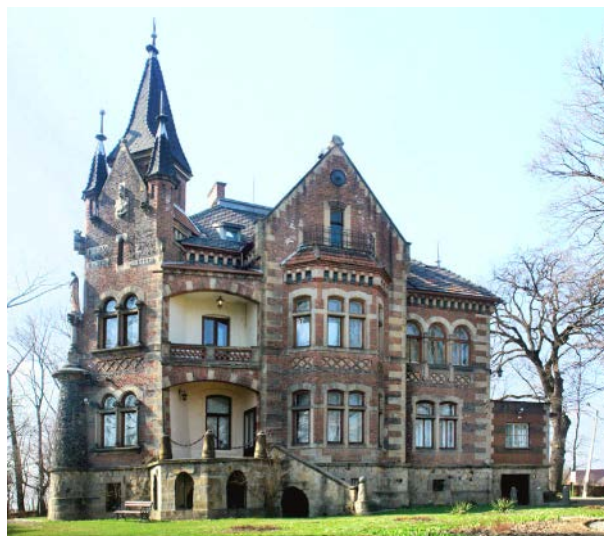
Ryc. 39. Dwór w Grodkowicach, elewacja wschodnia /fot. autora, 2011/
