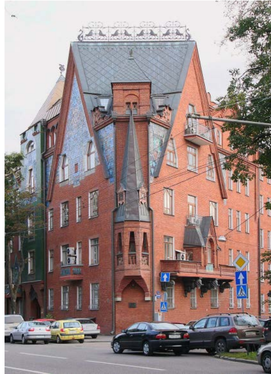
Ryc. 121. Kamienica Piercowa w Moskwie, arch. S. Maljutin, N. Żukow (1907) /fot. autora, 2008/ Fig. 121. Piercov house in Moscow, arch. S. Maljutin, N. Żukow (1907) /photo by author, 2008/
