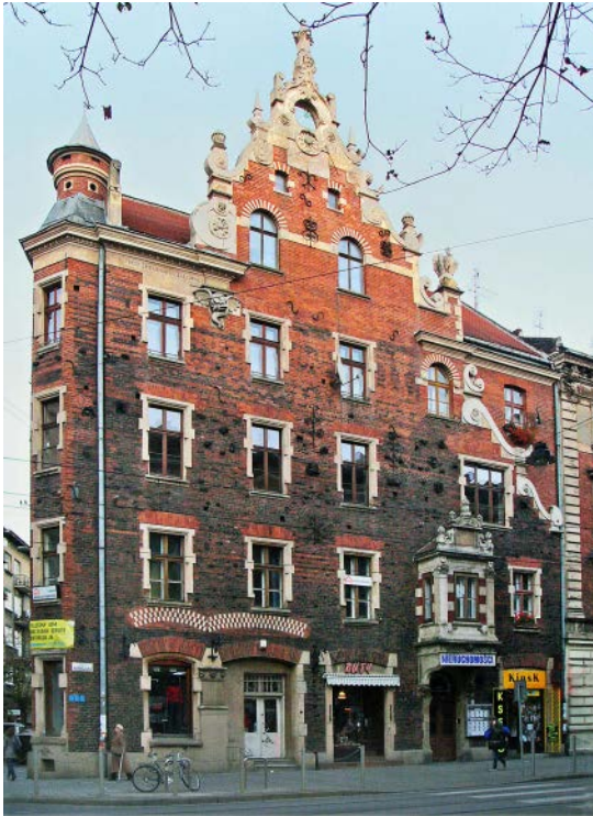
Ryc. 6. Dom Pod Pajakiem – elewacja frontowa /fot. autora, 2011/
