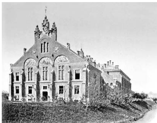
Rys. 43. Budynek Sokoła po rozbudowie, widok od str. istniejącej wtedy rzeki Rudawy
