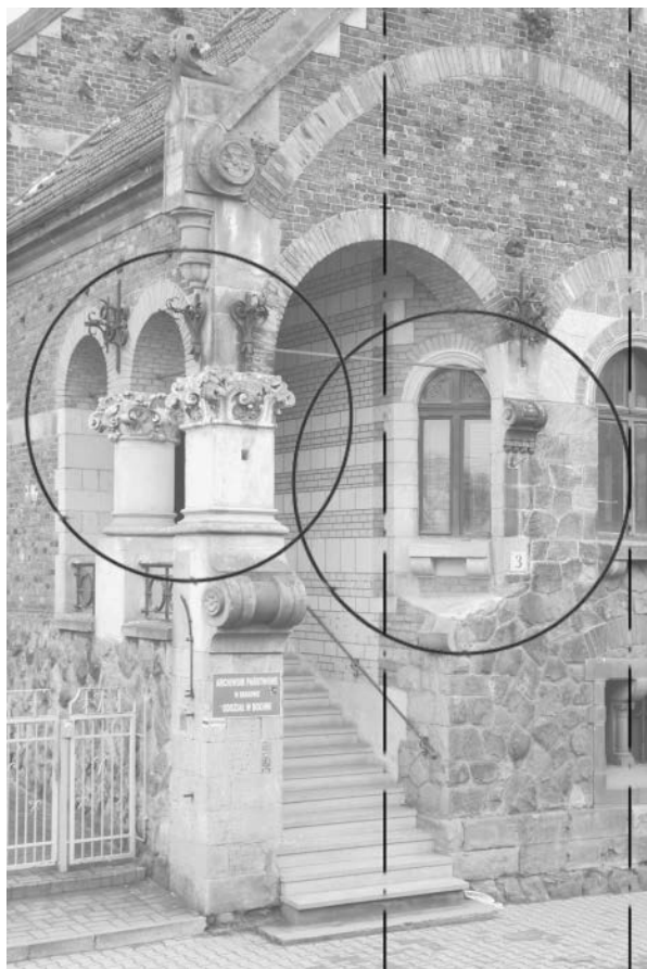
Ryc. 155. Główne elementy stopniowanego wejścia w willi w Bochni – okno ściętego narożnika, schody oraz ozdobne arkady /fot. autora, 2009/
