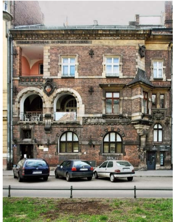
Ryc. 7. Dom Pod Osłem – elewacja frontowa /fot. autora, 2009/
