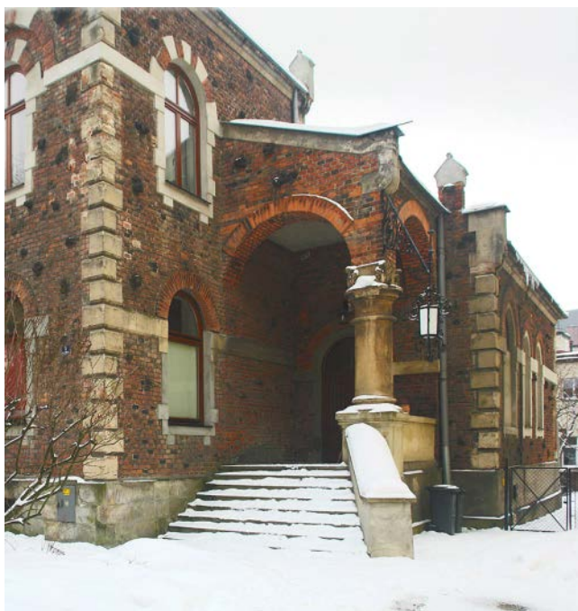
Ryc. 81. Podcień wejściowy willi w Jasle /fot. autora, 2010/ Fig. 81. The entrance arcade of villa in Jasło /photo by author, 2010/
