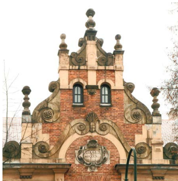
Ryc. 75. Ozdobny szczyt z kartuszem herbowym z datą budowy kamienicy przy ul. Retoryka 3 /fot. autora, 2012/
