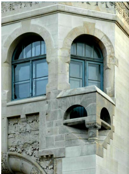
Ryc. 97. Budynek Politechniki Wrocławskiej arch. R. Plüddemann i K. Klimm (1904) /fot. autora, 2012/
