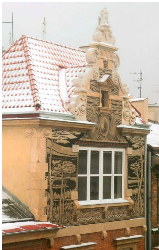
Ryc. 71. Pomieszczenie „malarni” na poddaszu kamienicy przy ul. Smoleńsk 20 /fot. autora, 2012/
