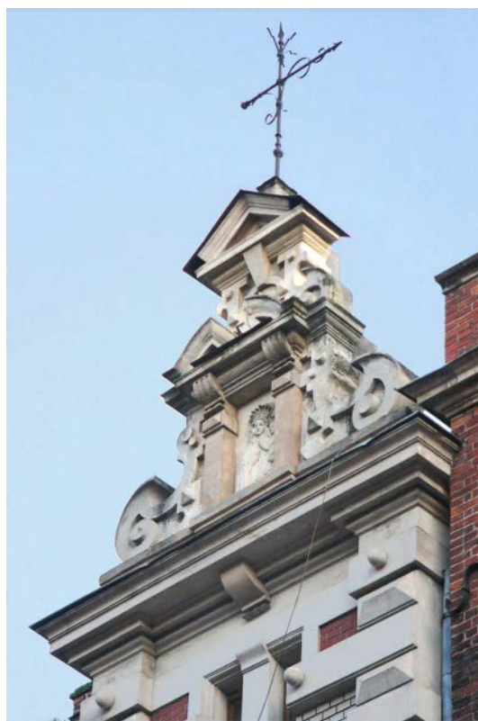
Ryc. 68. Szczyt kamienicy przy ul. Batorego 26, z płaskorzeźbą Matki Boskiej z Dzieciątkiem /fot. autora, 2011/
