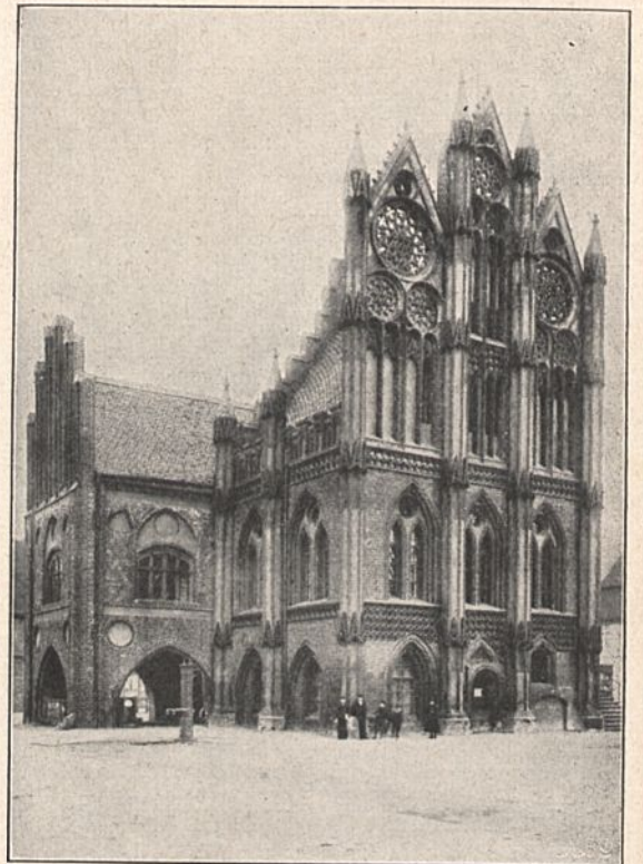
Fig. 29. Rathaus in Tangermünde um 1490. Formenreichtum des Giebels, der sich noch 5\frac{1}{2} m über den Dachfirst erhebt (Backstein).
