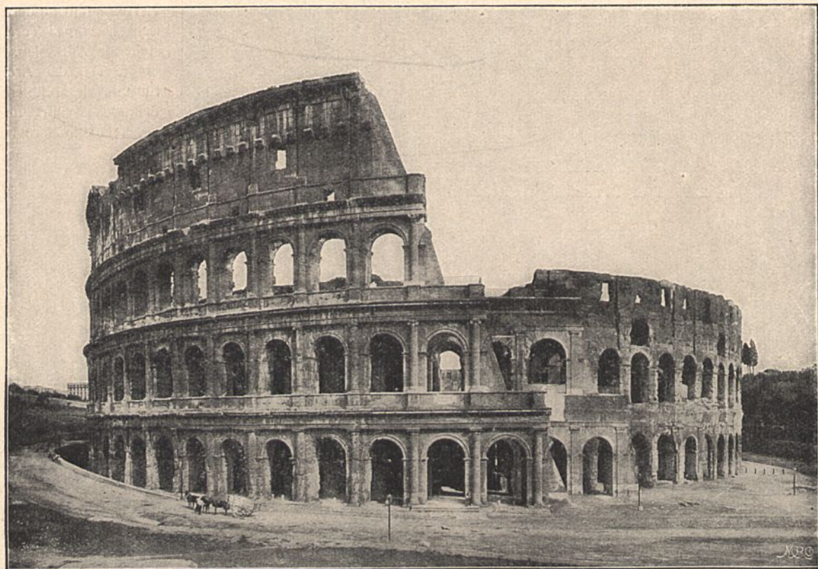
Fig. 234. Amphitheatrum Flavium, seit dem frühen Mittelalter Kolosseum genannt. Erbaut von Vespasian und Titus für etwa 45 000 Menschen. 48,5 m hoch. Dorische, ionische und korinthische Halbsäulen vor den Pfeilern der drei unteren Stockwerke; korinthische Pilaster an der Mauer des vierten Stockwerks.
