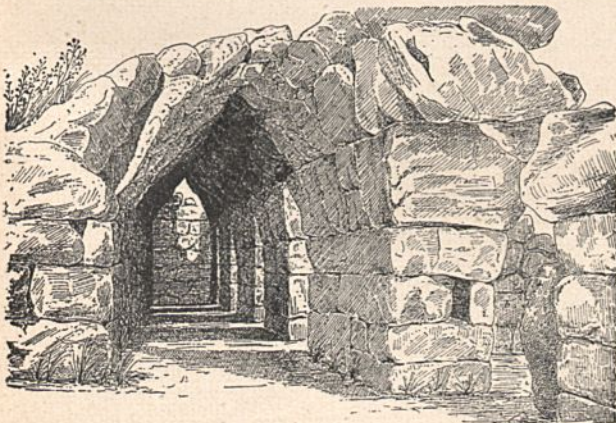
Fig. 33. Blick in die Galerie der Ostmauer G. Die Eingänge rechts führen in die (zerstörten) Kammern K.
