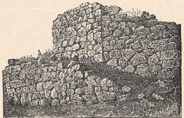
Fig. 34. Die Rampe im Osten mit einem Stück der Mauer und dem Turm.
