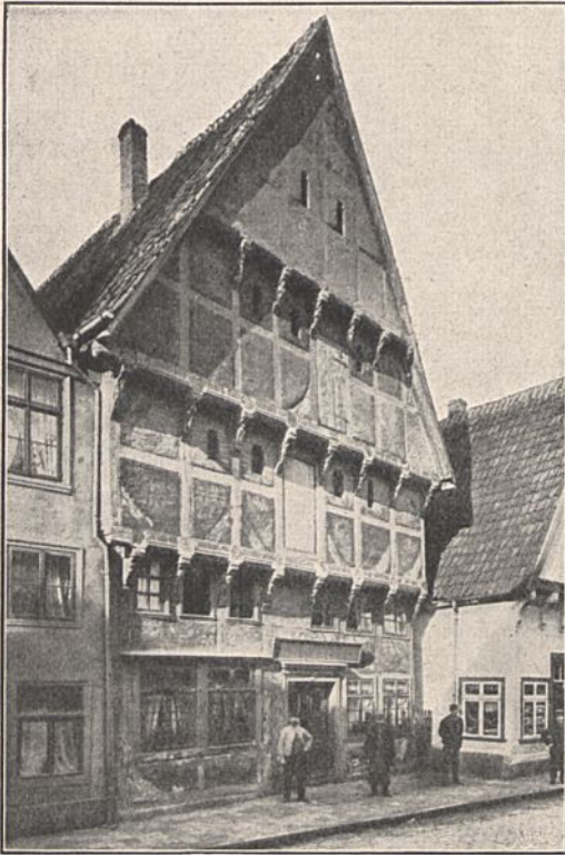
Fig. 26. Holzfachwerkhaus in Herford. Aus d. J. 1531 mit nach oben stets weiter vorkragenden Stockwerken.
