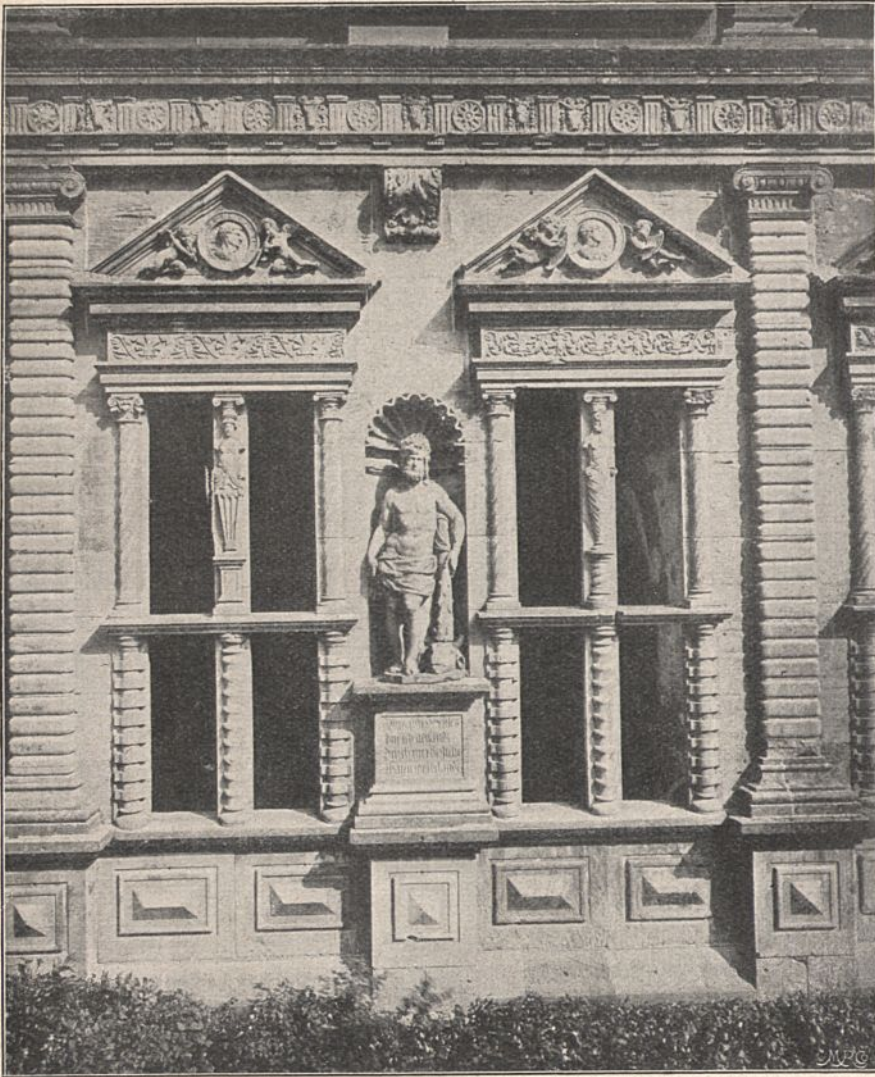
Fig. 126. Ottheinrichsbau, ein Feld des Erdgeschosses.
