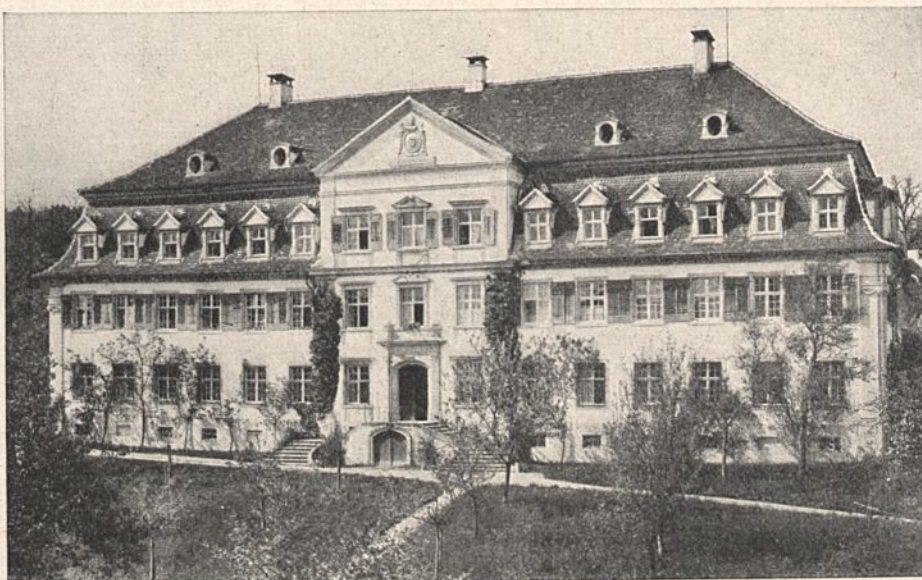
Fig. 41. Rentamt in Salem (Bodensee). Ende des 18. Jahrh.
