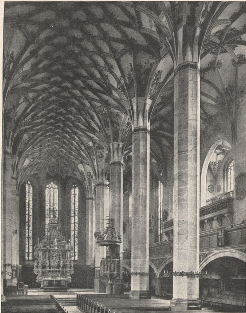
Fig. 77. Hauptkirche zu Pirna, eine Hallenkirche. 1504—1546. Achteckige Pfeiler ohne Kapitell tragen das Netzgewölbe, das ohne besondere Unterteilung durch Gurtbogen das ganze Kirchenschiff gleichmäßig bedeckt.
