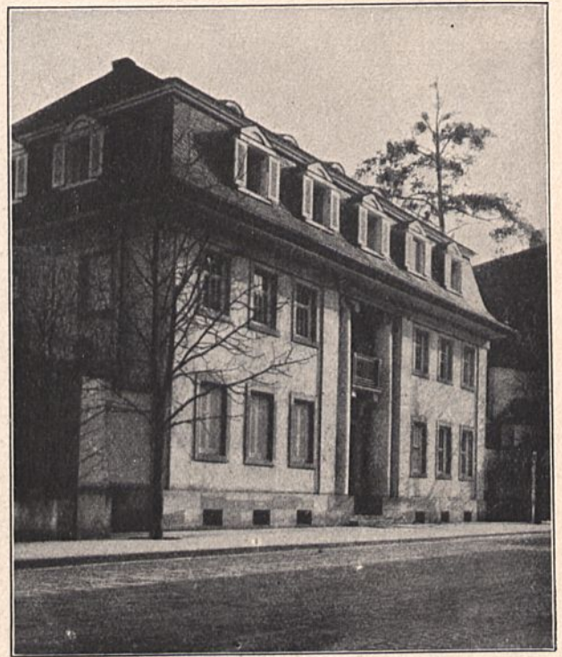
Fig. 22. Ostendorf, Wohnhaus in Karlsruhe.
