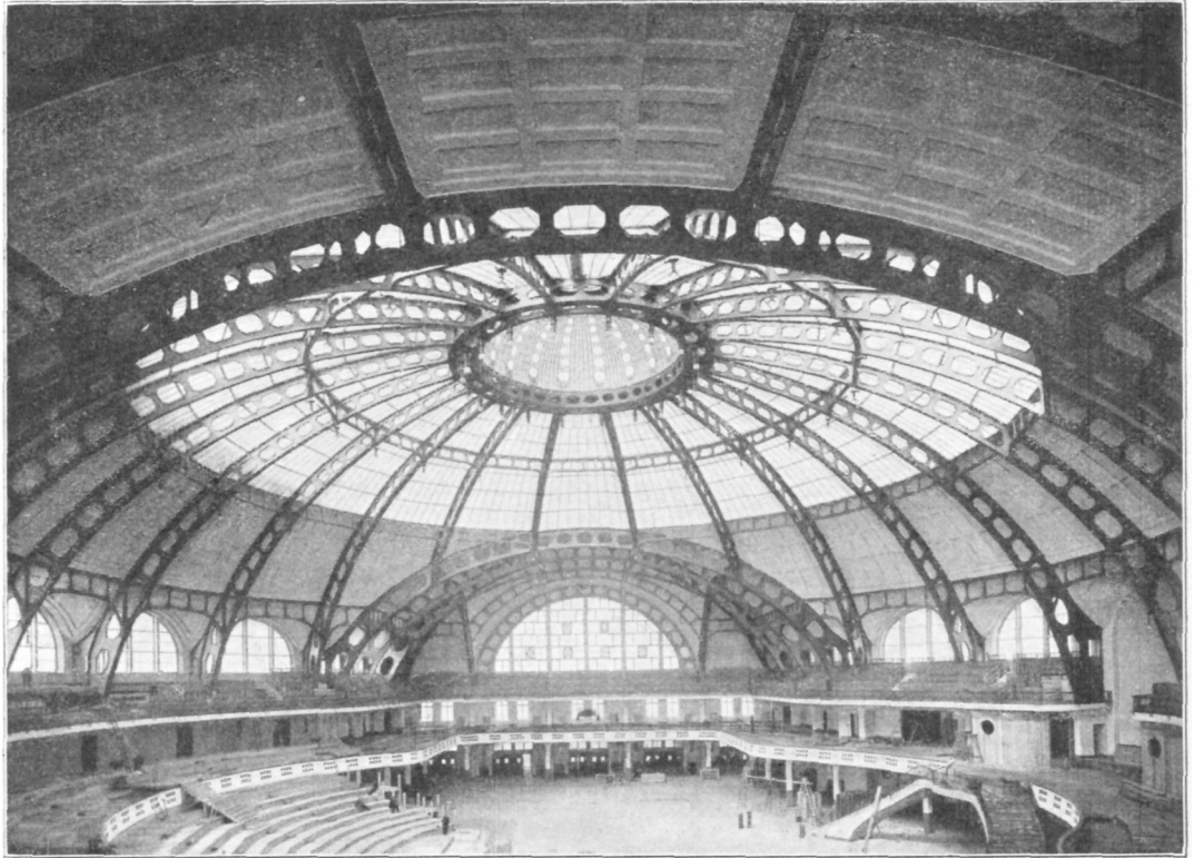
Abb. 105. Festhalle zu Frankfurt a. Main 1) . Innenansicht Arch.: Friedr. v. Thiersch
