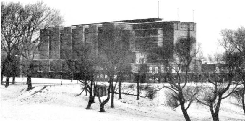
Abb. 81. Stadthalle Magdeburg Arch.: Johannes Göderitz
