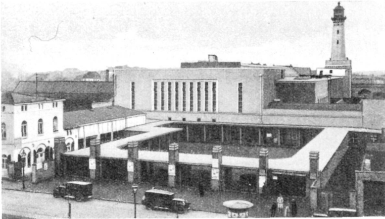
Abb. 145. Rheinlandhalle Köln. Außenansicht Arch.: Anton Schmitz
