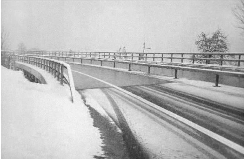
Rys. 7. Most w Därligen (RFN) z instalacją grzewczo-chłodniczą jego nawierzchni jako fragmentu autostrady A-8 [1,3]
