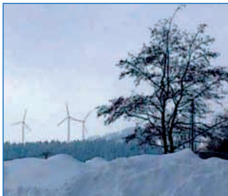
Fot. 37. Elektrownie wiatrowe w Ramzowej (Czechy) Pic. 37. Wind Farm in Ramzowa (The Czech Republic)
