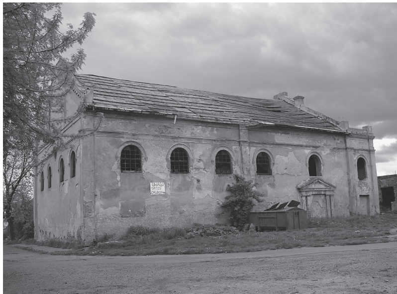
Ryc. 3. Budynek dawnej synagogi w Żychlinie, fot. A. Rykała
