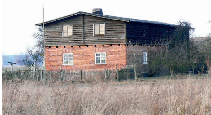
Przykład prawidłowego zachowania pierwotnego układu i wielkości otworów okiennych oraz ścian zewnętrznych we wsi Młodzianów Fot. B. Warczevska, W. Warczewski
