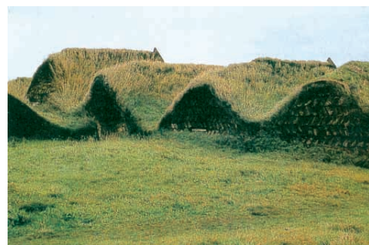
Tradycyjne domy Islandii pokryte darnią [Minke, Witter 1982]
