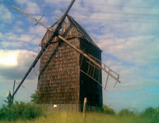
Zniszczony drewniany wiatrak typu koźlak we wsi Duchowo Fot. B. Warczevska
