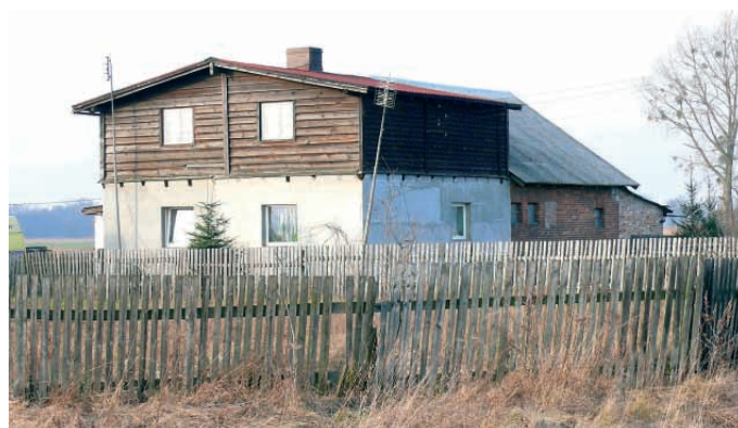
Negatywny przykład przebudowy pierwotnego układu i zmiany wielkości otworów okiennych, pokrycie ścian zewnętrznych tynkiem we wsi Młodzianów Fot. B. Warczevska, W. Warczewski
