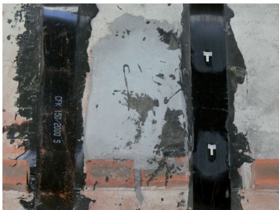
Rys. 4.99. Taśmy FRP CFK150/2000 przyklejone do łuku A3 w odstępach co 40 cm.
