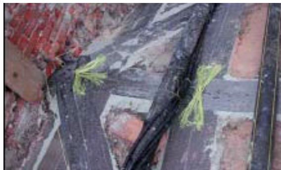
Rys. 3.120. Taśmy CFRP kotwione za pomocą wklejanych kotew z włókien aramidowych.
