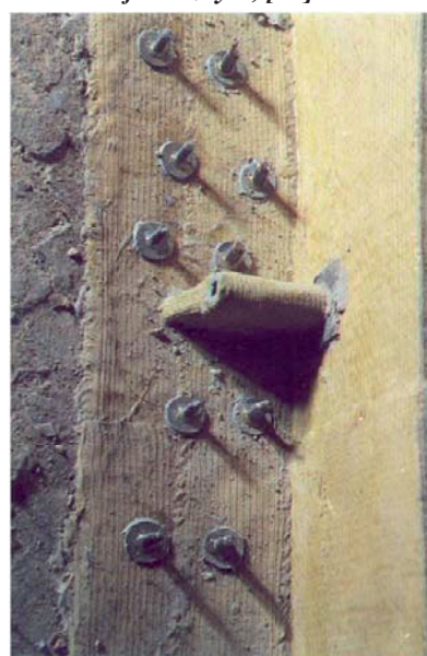
Rys. 3.111. Szczegół połączenia powłoki sklepienia z żebrem wzmocniającym, [60].
