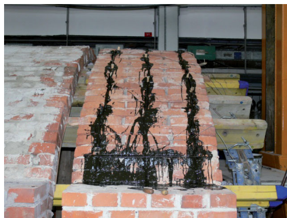
Rys. 4.144. Wzmacniające pręty stalowe zalane kompozycja klejową.
