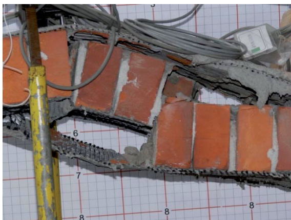
Rys. 4.131. Zniszczeni łuku (siła 26,368 kN).
