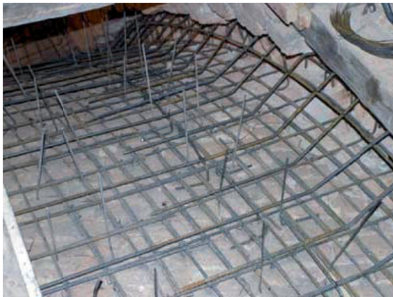
Rys. 3.100. Zbrojenie powłoki żelbetowej, widoczne stalowe kotwy zespajające, [117].
