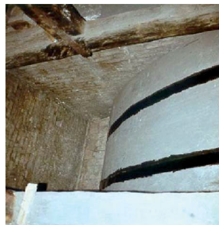
Rys. 3.129. Wzmocnienie sklepienia taśmami CFRP – Włochy 2001 r.
