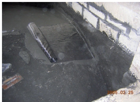
Rys. 3.150. Wzmacnianie sklepien w dawnej przetwórni tuńczyka na Sycylii.
