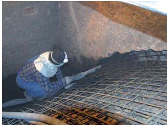
Rys. 3.101. Nakładanie torkretu na zbrojenie w strefie wieńca podporowego, [117].
