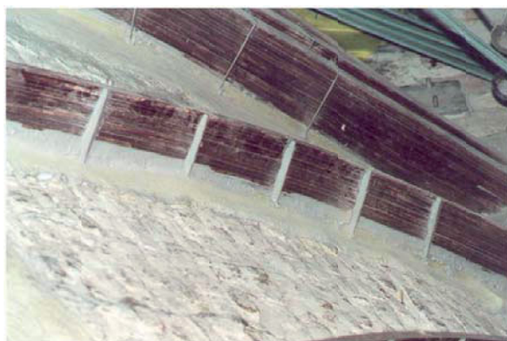
Rys. 3.106. Żebra w trakcie klejenia, [60].
