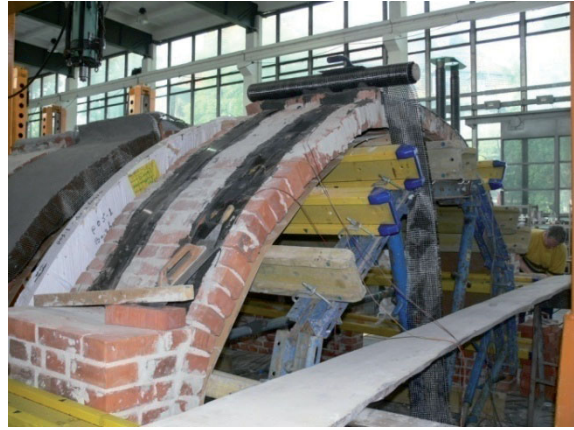
Rys. 4.102. Siatka z włókien węglowych w trakcie przyklejania na łuk i taśmy FRP w łuku A3.
