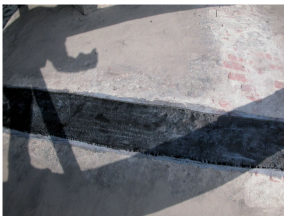
Rys. 3.130. Wzmocnienie sklepienia w Krakowie.
