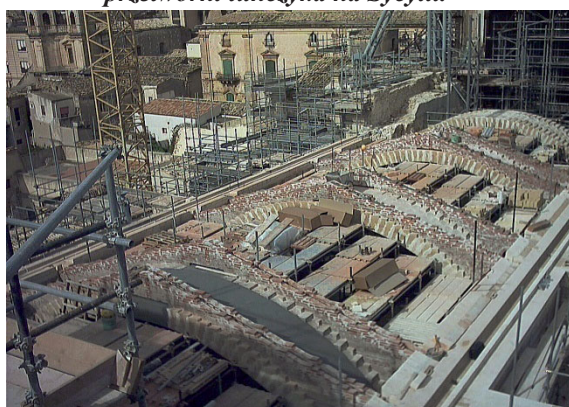
Rys. 3.151. Widok ogólny odtwarzanych sklepien katedry Noto.
