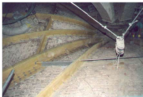
Rys. 3.107. Widoczne różnicowanie wysokości żeber, [60].
