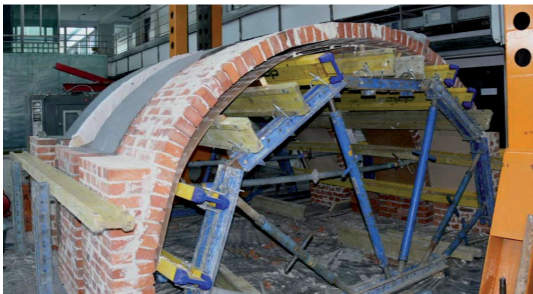
Rys. 4.57. Łuki na deskowaniu przenośnym typu TOP50.
