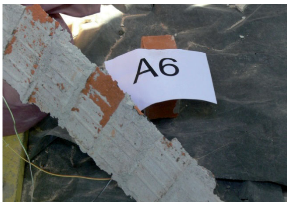
Rys. 4.176. Fragment łuku przyklejony do taśmy FRP po zniszczeniu łuku A6.
