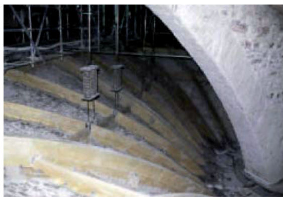
Rys. 3.109. Połączenie wzmocnionego sklepienia z konstrukcją dachu za pomocą sprężystego tłumika drgań – ze względu na położenie bazyliki w rejonie sejsmicznym, [60].
