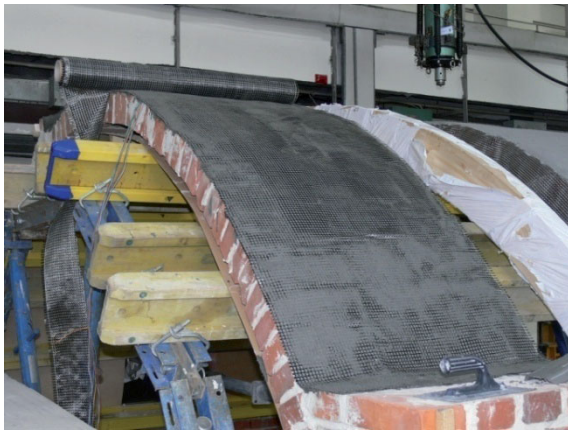
Rys. 4.103. Łuk A3 z świeżo naklejoną siatką z włókna węglowego, bez górnej warstwy zaprawy.
