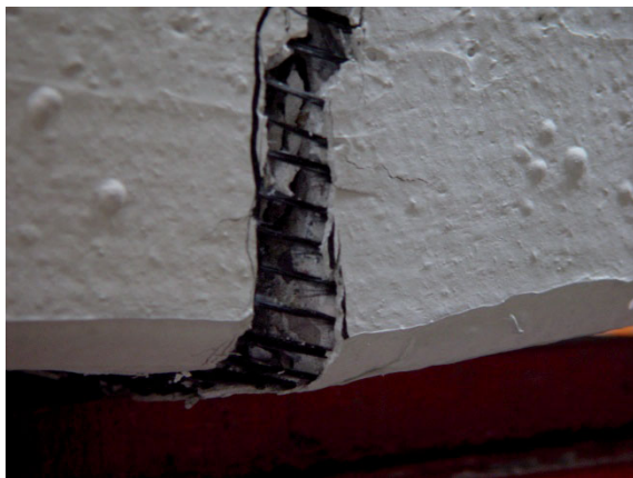
Rys. 3.147. Belka żelbetowa wzmocniona FRCM.
