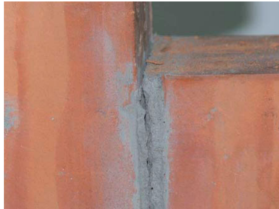
Rys. 4.39. Próbkę s1 – widoczna powierzchnia ścinania.
