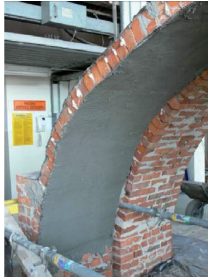
Rys. 4.127. Wzmocnienie FRCM po stronie podniebienia łuku A4.
