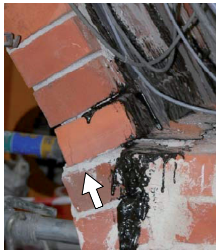
Rys. 4.166. Ścinanie na podporze 'B' (siła ok. 15 kN).
