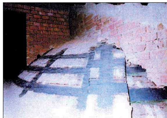
Rys. 3.125. Wzmocnienie sklepienia matami z włókien węglowych CFRP.
