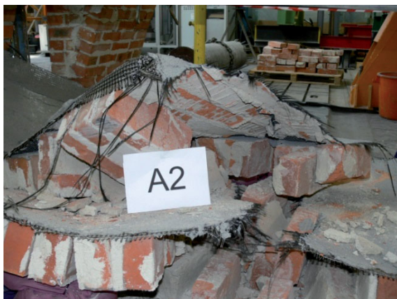
Rys. 4.87. Zniszczony łuk A2, widoczna rozerwana siatka z włókna węglowego.
