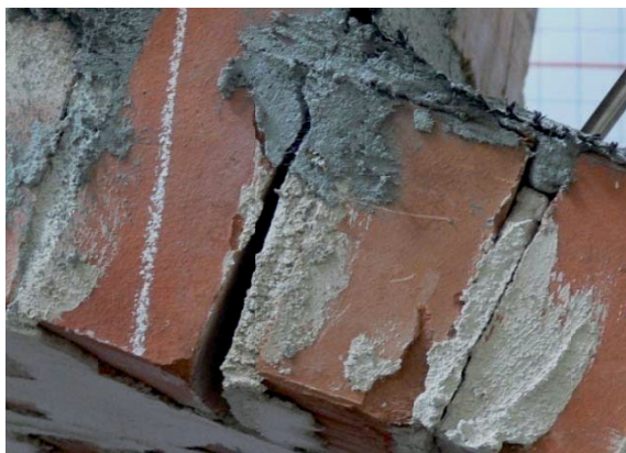
Rys. 6.1. Powstanie przegubu o środku obrotu w części górnej połączenia.
