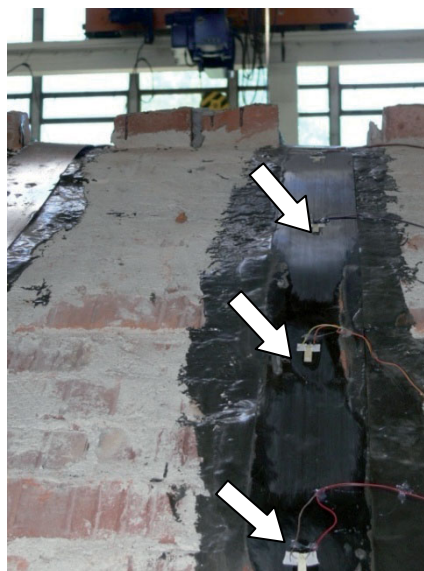
Rys. 4.98. Taśmy FRP CFK150/2000 z tensometrami przyklejone do łuku A3.
