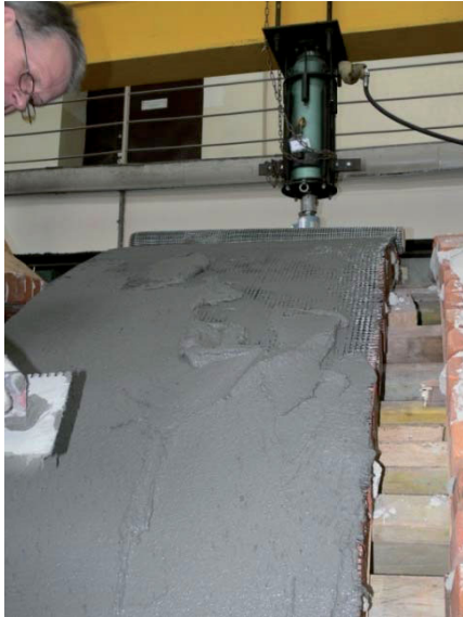
Rys. 4.126. Druga warstwa zaprawy we wzmocnieniu FRCM.
