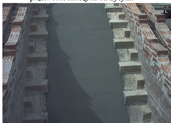
Rys. 3.152. Wzmocnienie FRCM w katedrze w Noto- Sycylia.
