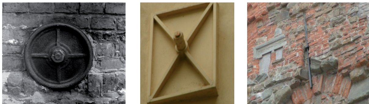
Rys. 3.78. Różnego rodzaju elementy oporowe zakotwień ściągu stalowych, [117].
