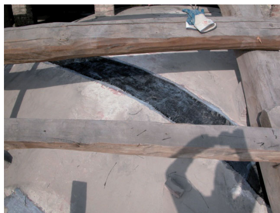
Rys. 3.131. Wzmocnienie sklepienia w Krakowie.
