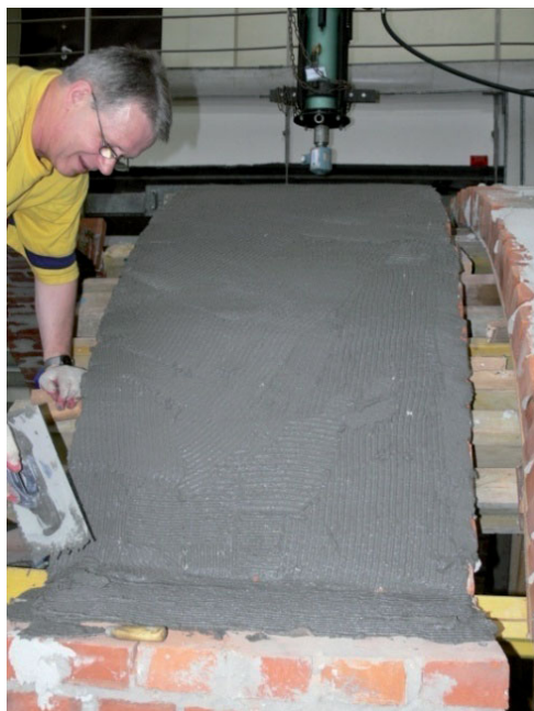
Rys. 4.124. Pierwsza warstwa zaprawy we wzmacnieniu FRCM.
