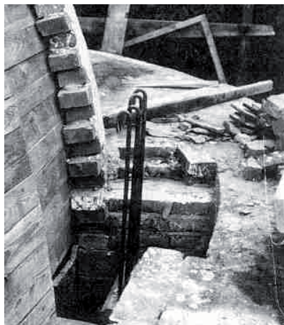
Rys. 3.96. Sklepienie absydy romańskiego kościoła pw. św. Mikołaja i Wniebowzięcia NMP w Gieczu w trakcie rekonstrukcji. Widoczne pręty w murze dla zakotwienia żelbetowej konstrukcji wzmacniającej, [135].
