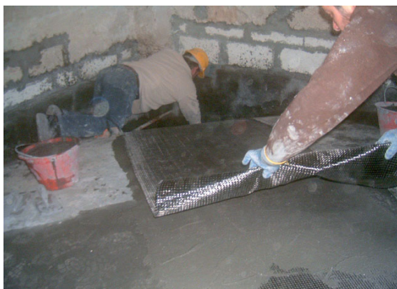
Rys. 3.149. Wzmacnianie sklepien w dawnej przetwórni tuńczyka na Sycylii.
