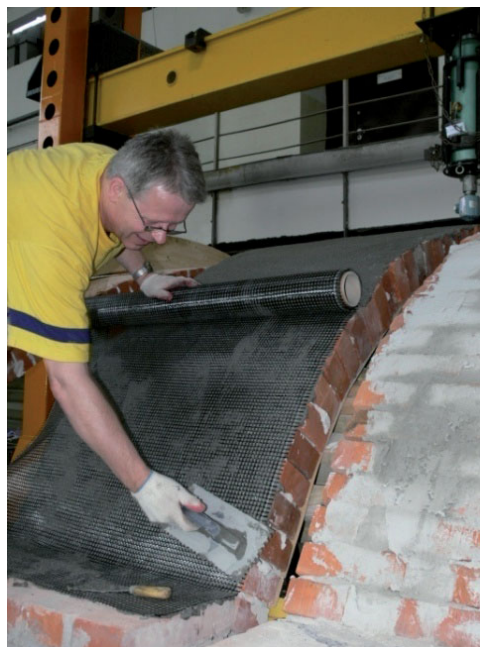
Rys. 4.125. Przyklejanie siatki z włókna węglowego na łuk A4.
