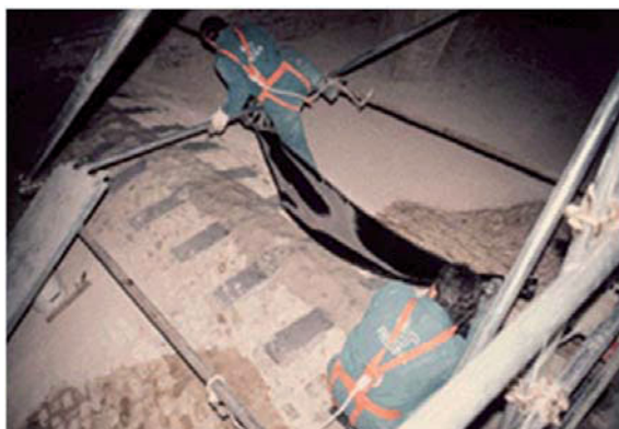
Rys. 3.126. Wzmocnianie sklepień ceglanych w bazylice św. Franciszka w Asyżu przy pomocy mat z włókien węglowych, [60].
