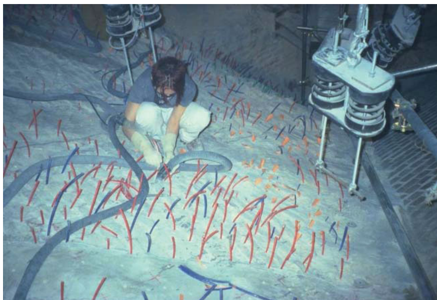
Rys. 3.154. Iniekcja strukturalna sklepienia bazyliki św. Franciszka w Asyżu, [60].
