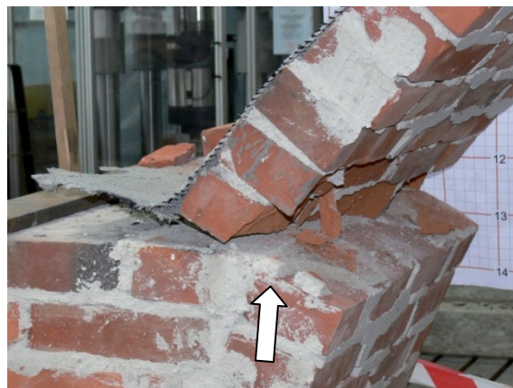
Rys. 4.112. Zmiażdżone cegły w podporze lewej 'A', widoczne odspojenie statki wzmacniającej od podpory.
