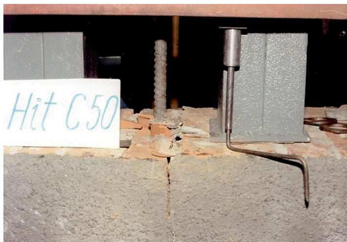
Rys. 3.91. Zniszczenie połączenia – kompozycją H – HIT C50, [123].
