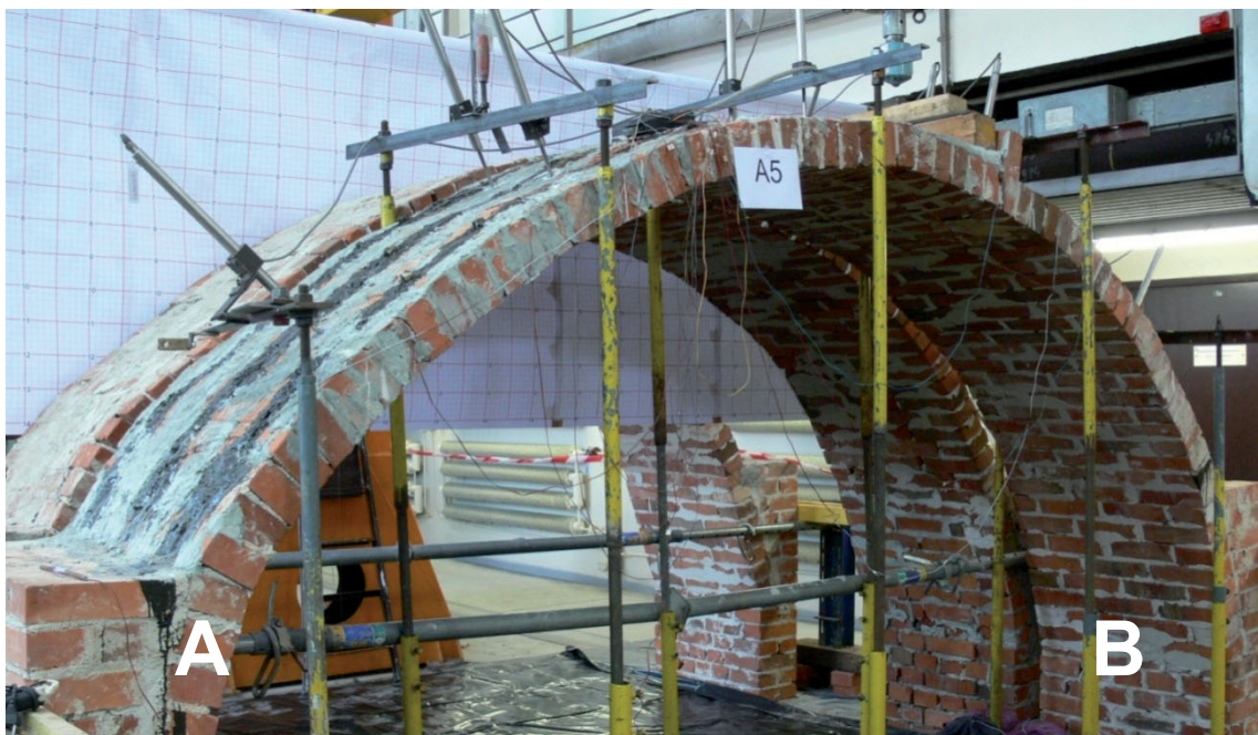
Rys. 4.140. Łuk A5 – widok ogólny (opisane podpory A i B).
