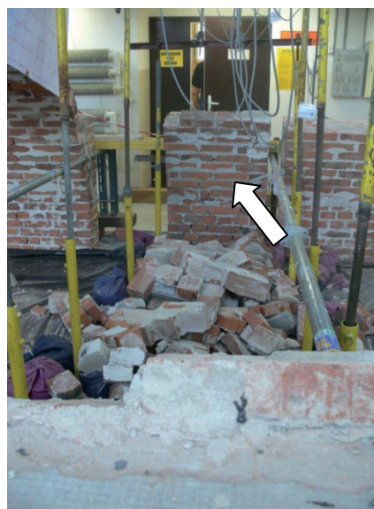
Rys. 4.67. Podpora B oraz pozostałości łuku A1.
