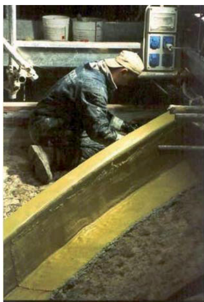
Rys. 3.110. Żebro oklejone matami aramidowymi, [60].
