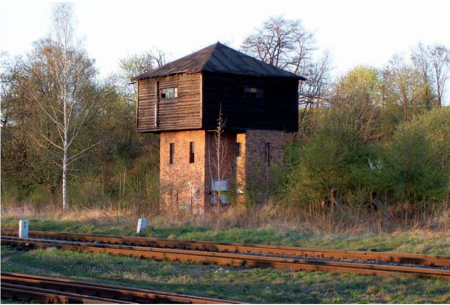
Ryc. 1. Stacja Głuchołazy – wieża wodna
