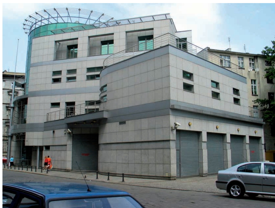
Ryc. 2. Elewacja wykonana z granitu strzegomskiego, siedziba NBP we Wrocławiu, ul. Lelewela (fot. S. Mazurek)
