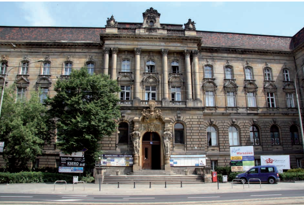
Ryc. 7. Elewacja budynku NOT, Wrocław, ul. Piłsudskiego 74; piaskowiec na budowę w latach 1894-1896 dostarczała firma Zeidler & Wimmel i określiła go jako „piaskowiec śląski” (fot. M.W. Lorenc)
