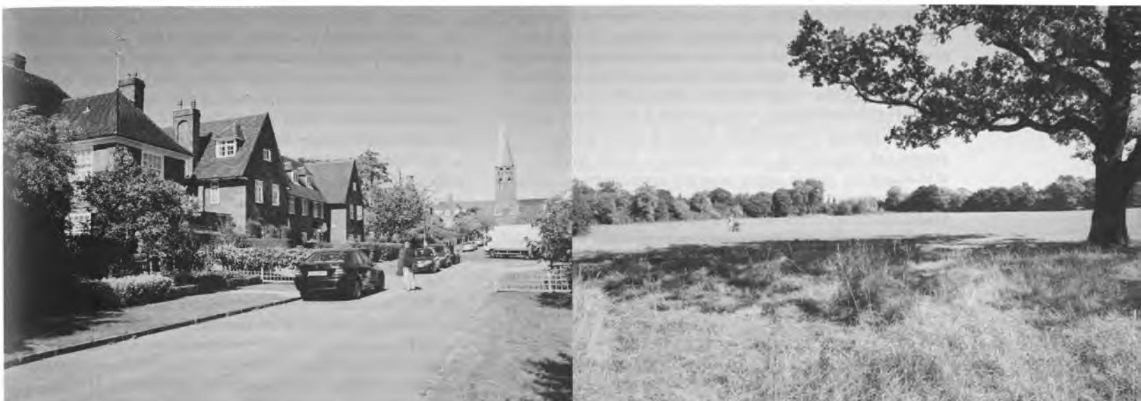
Dominująca nad Central Square wieża kościoła św. Judy, naprowadzająca wzrok na główną oś kompozycyjną przestrzennego układu zabudowy Hampstead Garden Suburb, przebiegająca przez nienaruszalną strefę zieleni Hampstead Heath Extension. Tonące w zieleni zaaranżowane układy domów nadają uliczkom Hampstead indywidualny charakter Fot. B. Wojtyśzyn, A. Kwaśniewski
