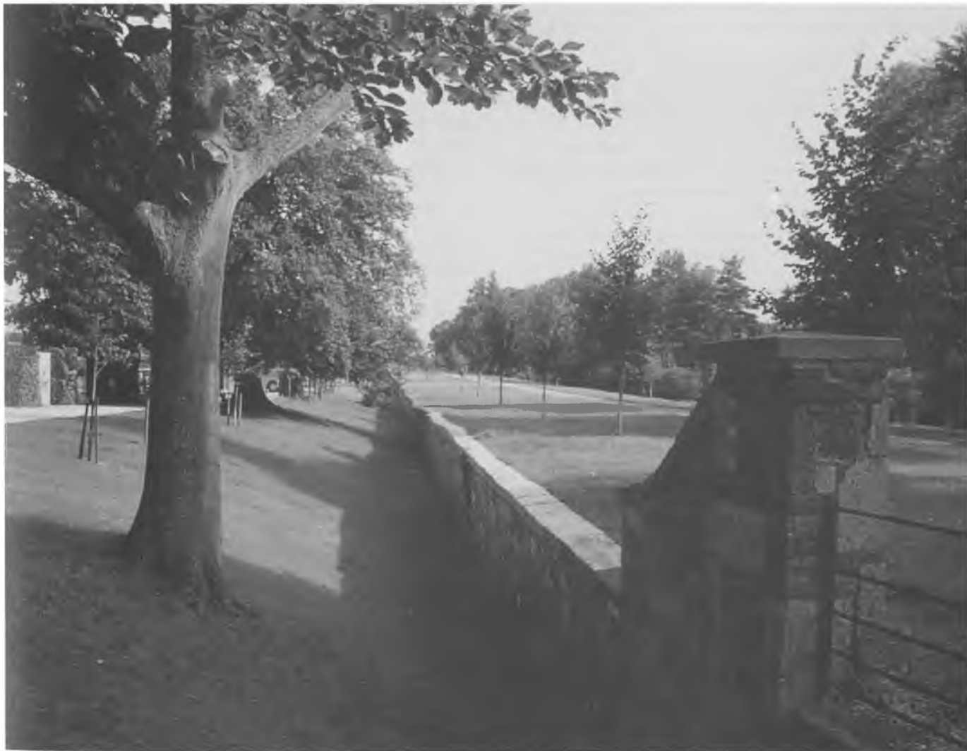
Stowe. Ogrodzenie typu aha w północnej części ogrodu, z lat 30 XVIII wieku Fot. P. Ogielski
