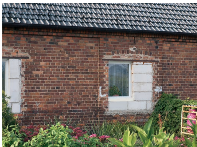
Ryc. 6. Miłoszki, przykładowa „wymiana” stolarki okiennej
