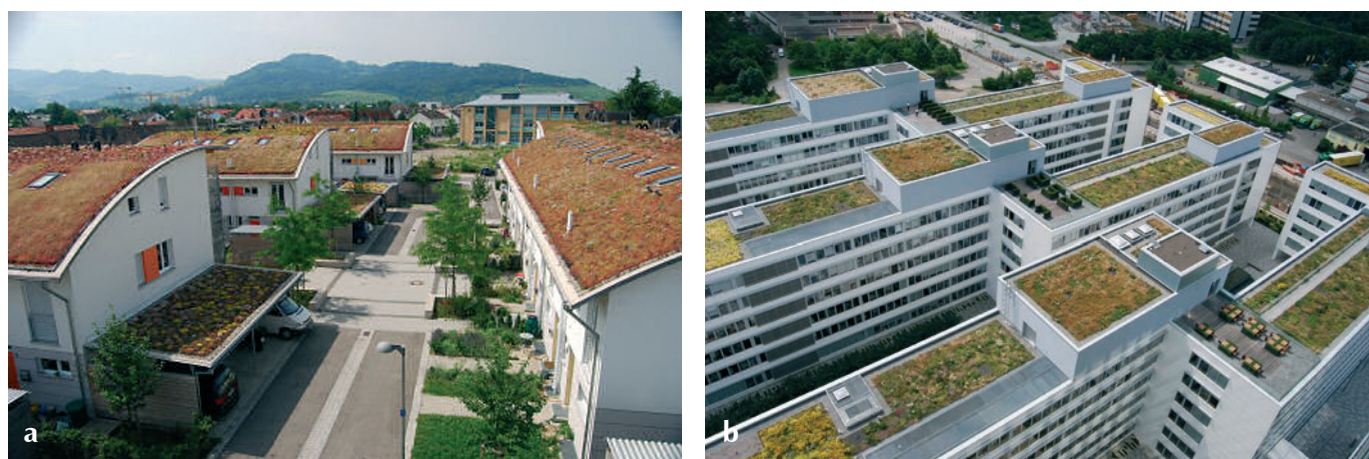
Ryc. 3. Zwiększenie retencyjności obszarów zabudowanych przez zastosowanie dachów zielonych a) domy szeregowe osiedla „Rosengarten” we Freiburgu, b) kompleks biurowy w dzielnicy przemysłowej na wschód od Stuttgartu Fasanenhof (źródło: rozwiązania systemowe Optigrün)
