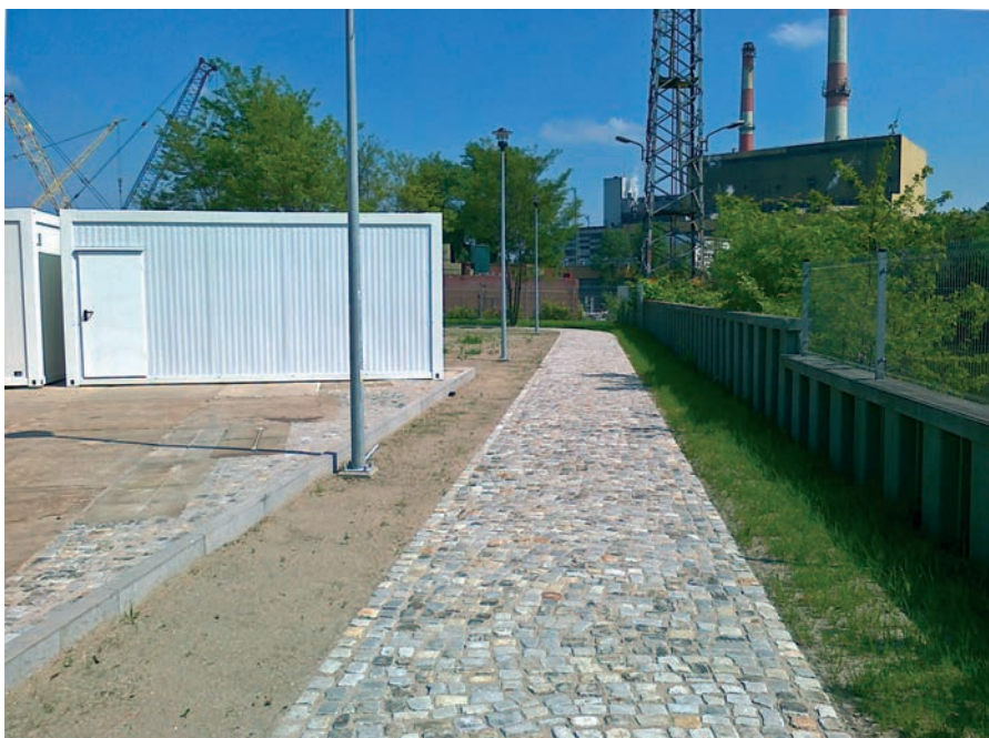
Ryc. 5. Budowa ścieżki edukacyjnej (wrzesień 2011 r.)
