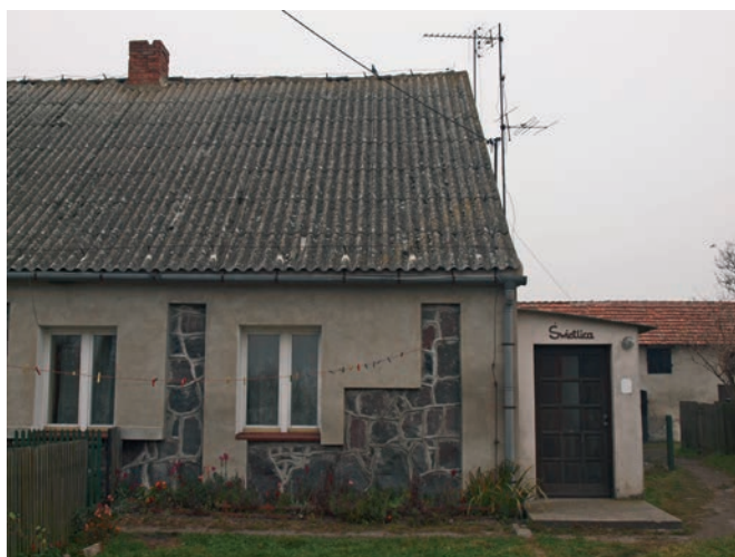
Ryc. 5. Grodzisko, przykład nieprofesjonalnie przeprowadzonej rewaloryzacji elewacji
