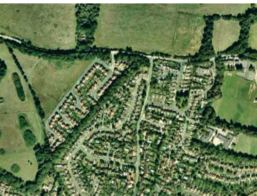
Ryc. 5. Zabudowa podmiejska w Londynie [2]
