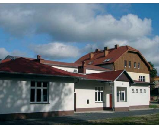
Ryc. 14a i 14b. Remont połączony z modernizacją budynku świetlicy wiejskiej w Mściwojowie (gm. Mściwojów, woj. dolnośląskie), źródło: http://www.msciwojow.pl/pl/Swietlice-wiejskie,143
