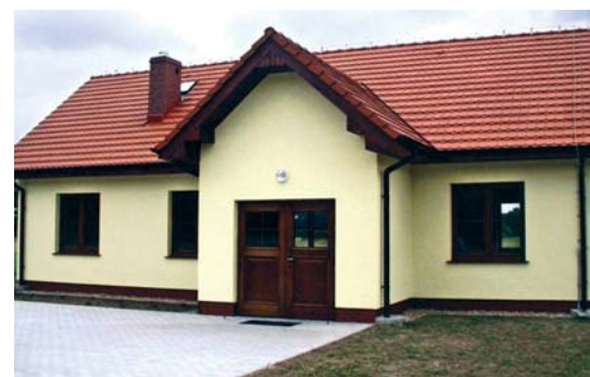
Ryc. 15. Budowa świetlicy wiejskiej wraz z terenem rekreacyjnym w Miodarach (gm. Dobroszyce, woj. dolnośląskie), źródło: Dobre praktyki w PROW 2007–2013 , pod red. J. Gontarz, I. Gutowska, Urząd Marszałkowski Województwa Dolnośląskiego, 2010
