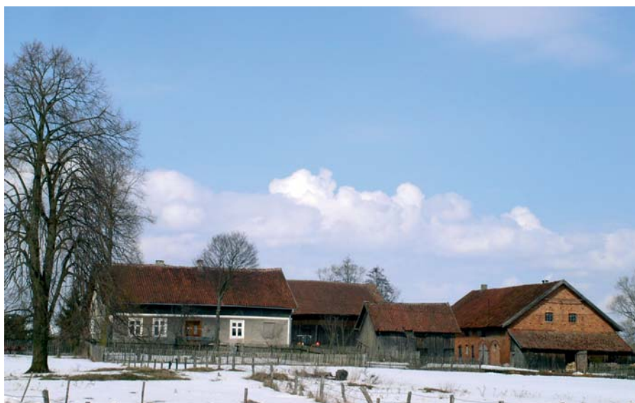
Ryc. 2. Prasłity, pow. olsztyński, gospodarstwo kolonijne z typowym, czworobocznym układem zagrody i budynkami
