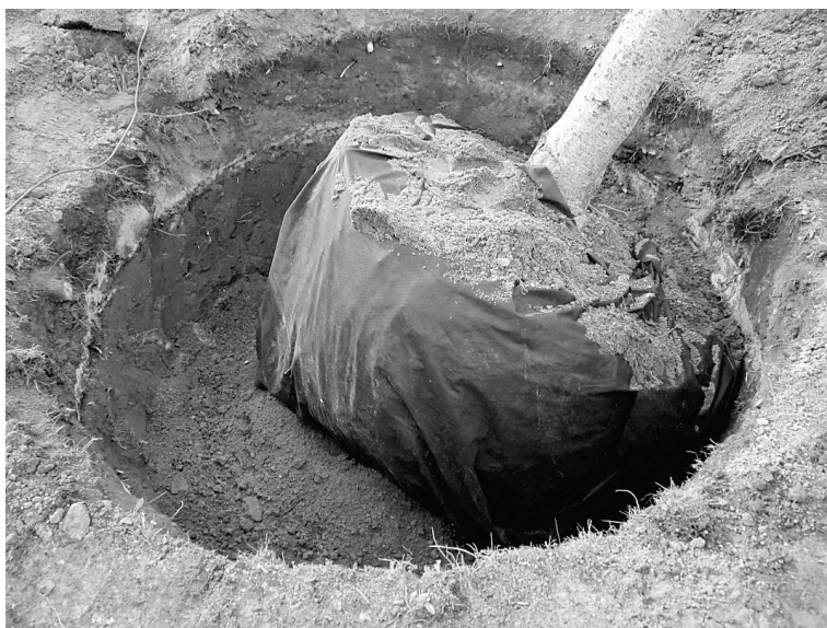
Fot. 1. Prace przy wykonaniu próby przesadzenia drzew
