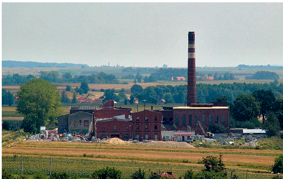
Fot. 5. Widok na ruiny Cukrowni „Żąbkowice Śląskie” w 2008 r.
