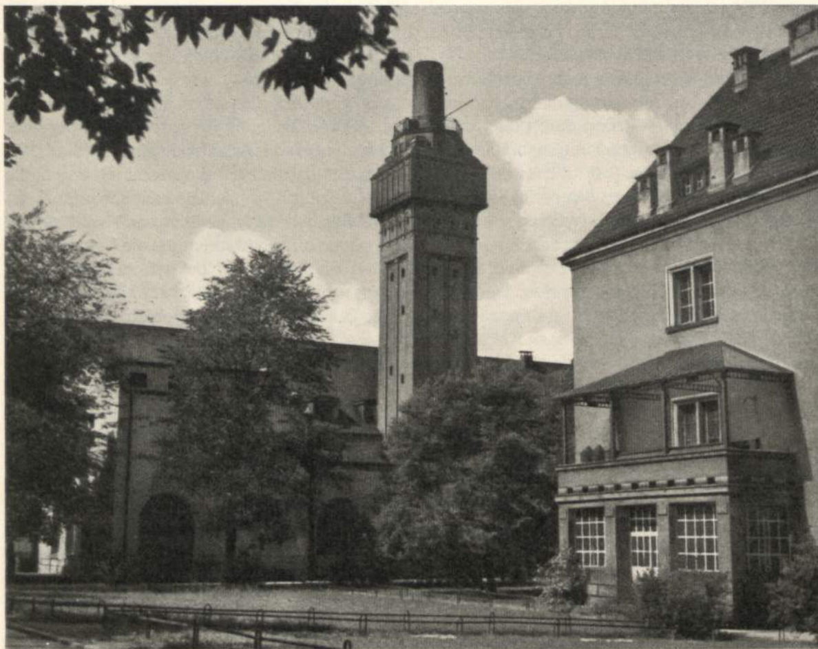
Das Wahrzeichen der Hochschule, zugleich Esse und Wasserturm, am Maschinenhaus
