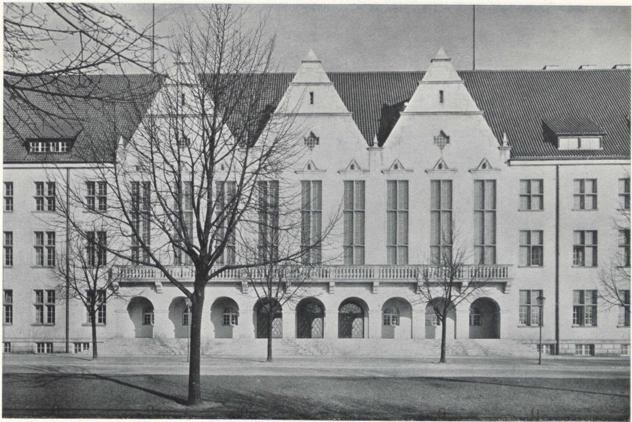
Abb. 2. Ansicht des neuen Hauptgebäudes der Technischen Hochschule.
