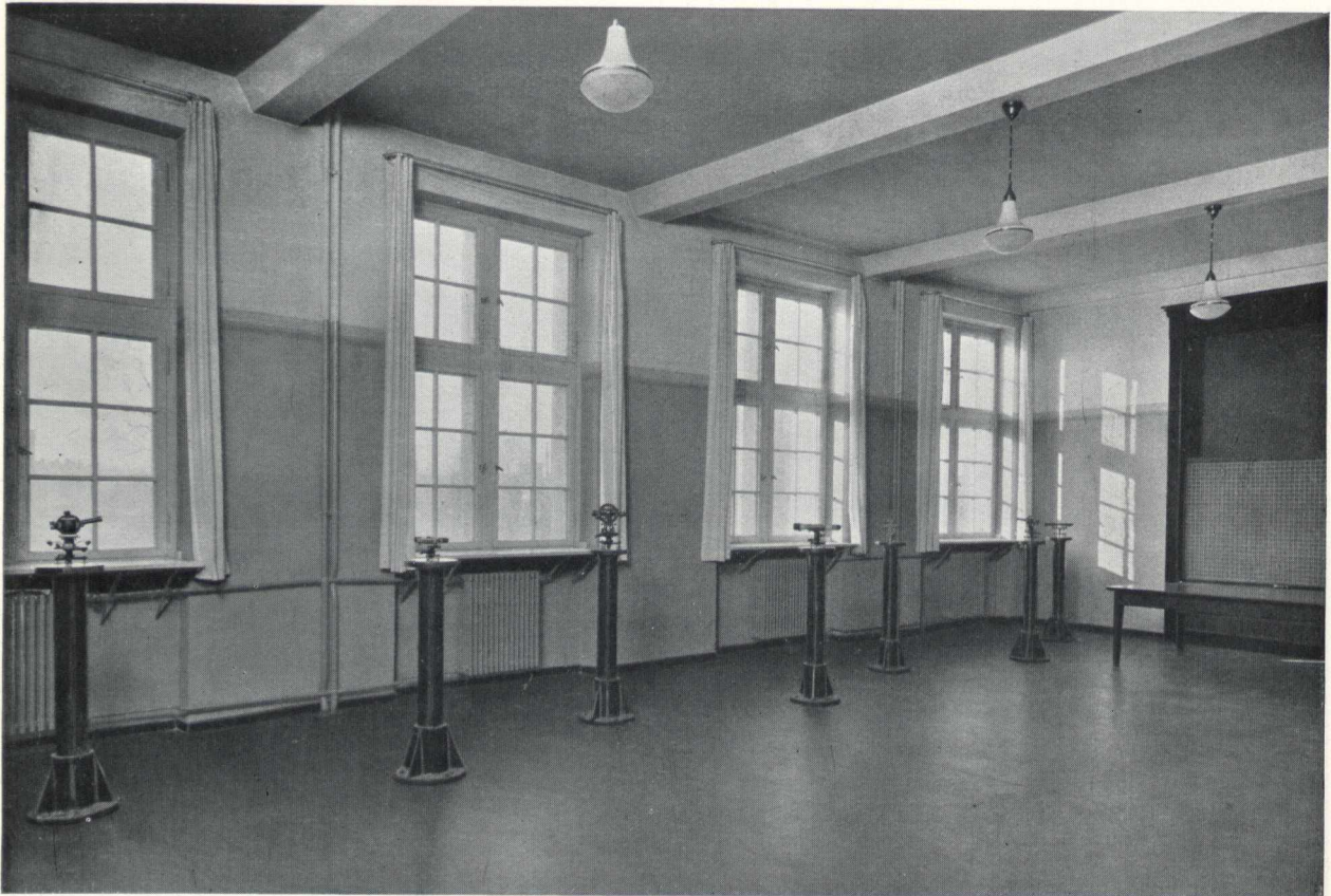
Abb. 5. Instrumentenpfeiler im Übungssaal.
