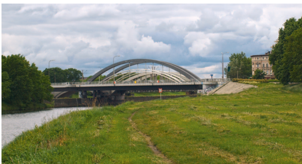
Ryc. 72. Obszar II – Karłowice 3 – widok w kierunku zachodnim. Od lewej: kanał Powodziowy, „nowy” most Warszawski zachodni, zabudowa naroża ul. Galla Anonima i al. Kromera (fot. J. Gubański, 2013 r.) Fig. 72. Area II – Karłowice 3 – westward view. To the left: Flood Control Channel, „new” Warszawski Zachodni Bridge, development of Galla Anonima Street and Kromera Ave. corner (photo J. Gubański, 2013)
