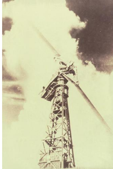
rys. 8. Pierwsza na świecie elektrownia wiatrowa o mocy powyżej 1 MW [NREL Image Gallery]
