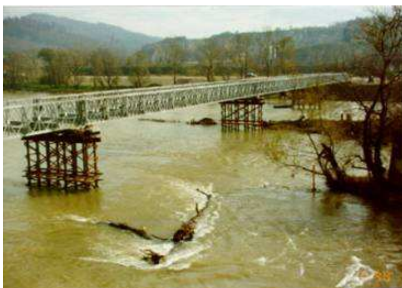
Rys. 5. Most tymczasowy w nowej osi po przejściu fali powodziowej
