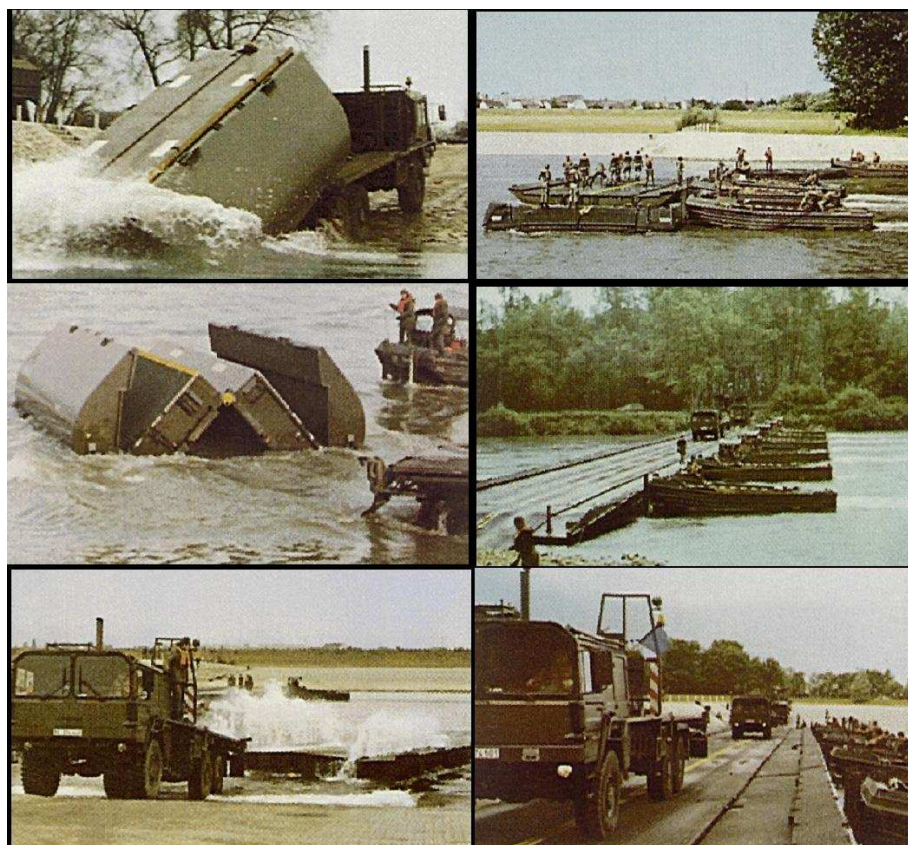
Rys. 3 Montaż mostu FSB-2
