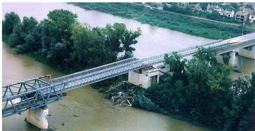
Rys. 4. Odbudowa mostu w starej osi.
