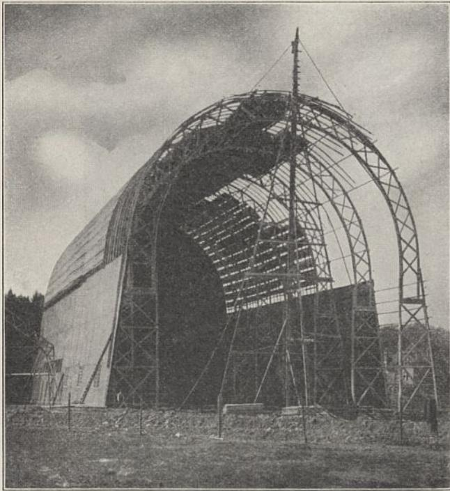
Abb. 57. Einschiffige Bergungshalle in Holz.
