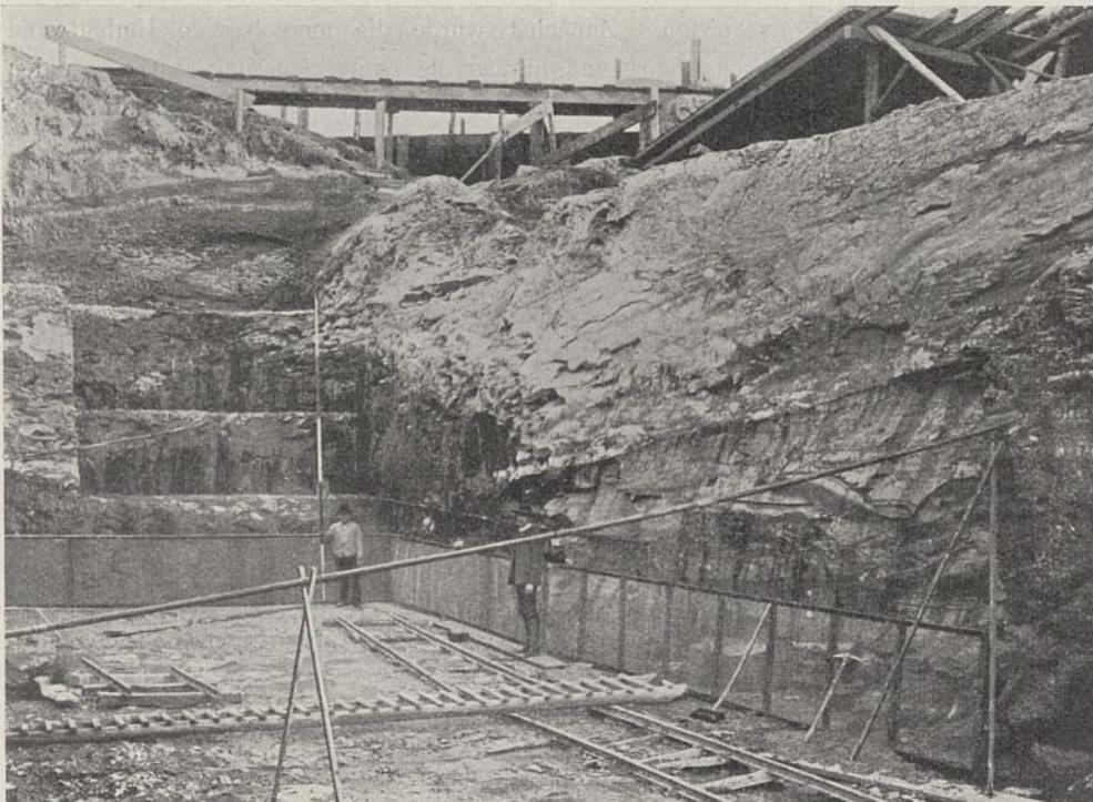
Abb. 8. Baugrube am Oberhaupt unmittelbar vor der Betonierung mit den aufgestellten Draht- geflechtem zur guten Ausfüllung der Zwischenräume zwischen den Kammermauern und Mergelwänden.
