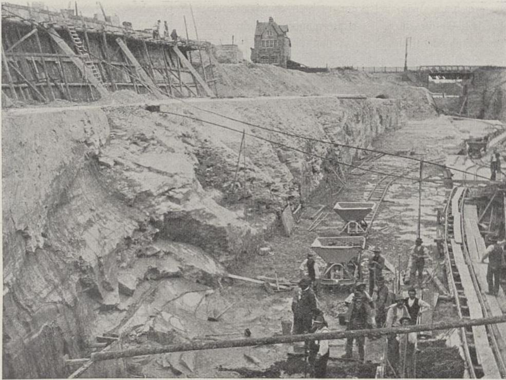
Abb. 7. Blick in die Baugrube, links die abgestürzten Mergelwände und die Mauer zwischen Oberhafen und Sparbecken.
