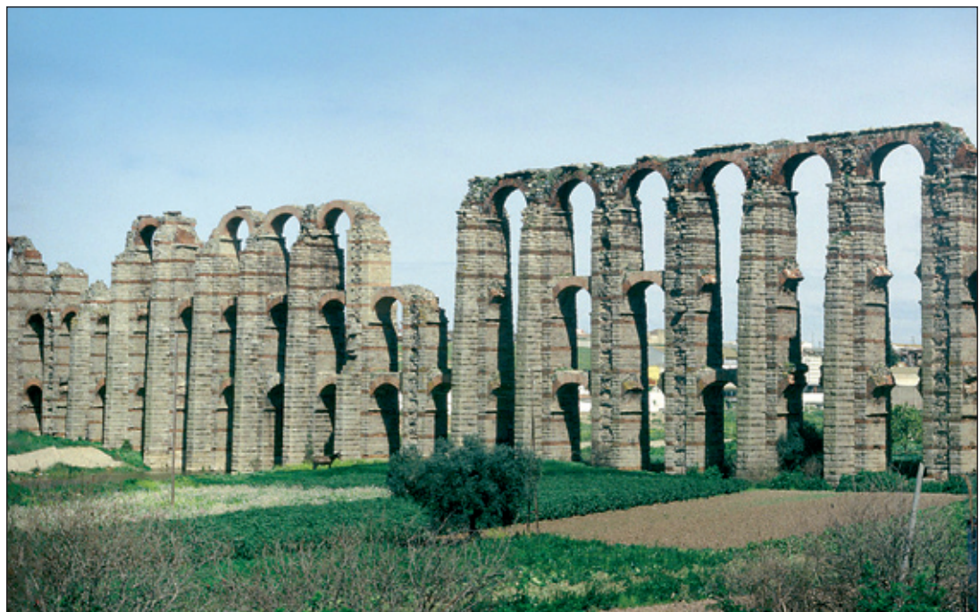
Mérida, rzymski akwedukt (Acueducto de los Milagros) długości 827 m
