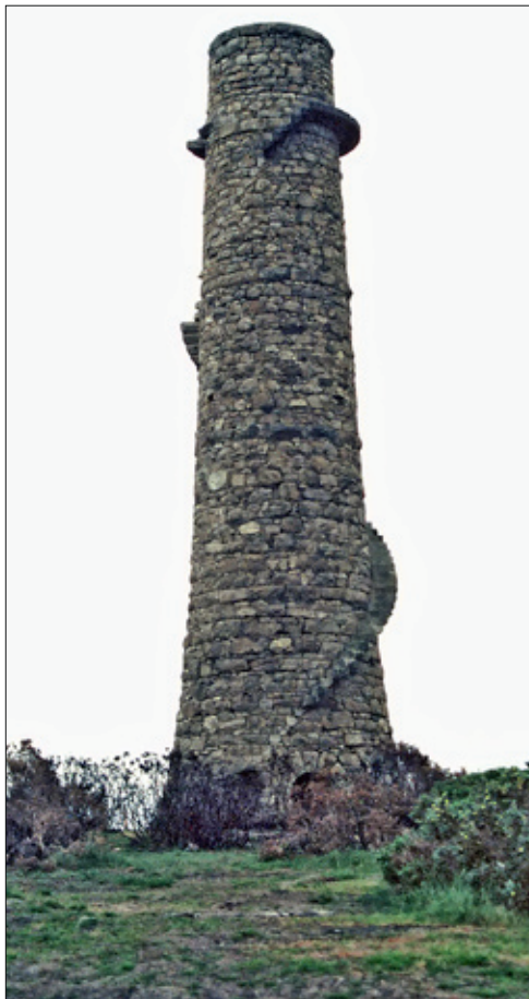
Ballycorus , komin (wys. 25 m) wyprowadzający lotne produkty huty ołowiu, wzniesiono na wzgórzu w odległości ok. 1000 m i 120 m wyżej od zakładu.
