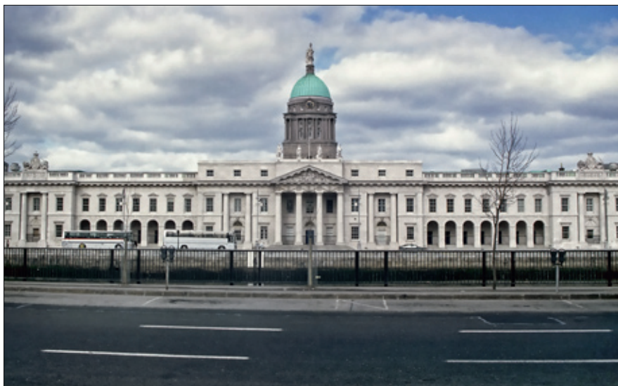
Dublin , Custom House – Urząd Celny
