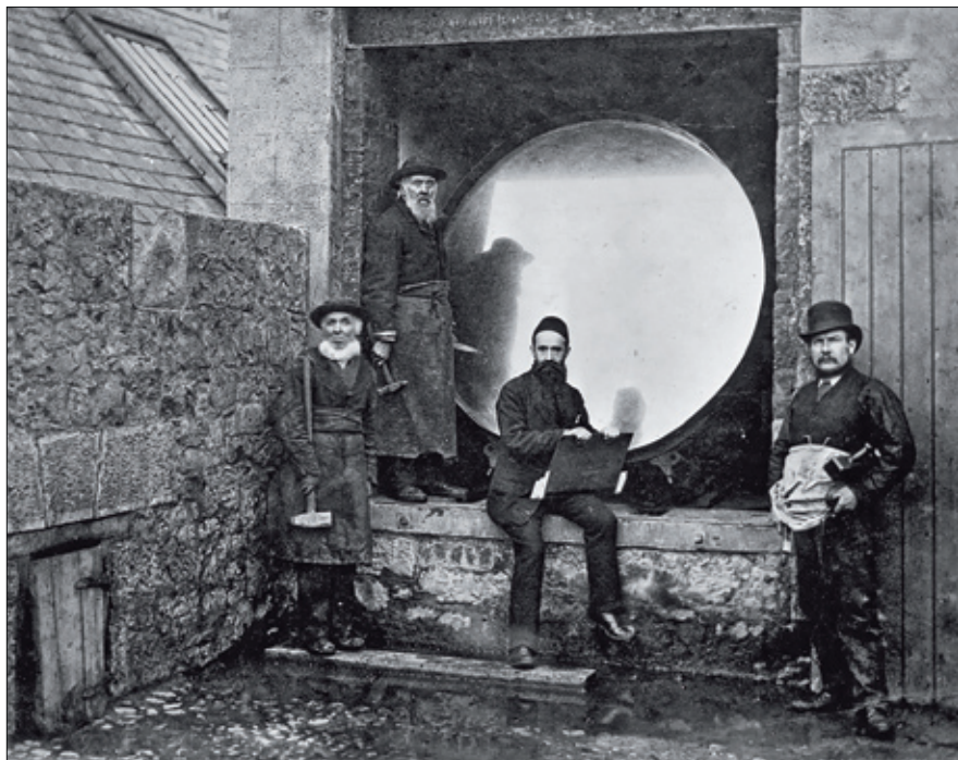
Birr , nowe zwierciadło wielkiego teleskopu po ukończeniu polerowania w 1844 r. (fotografia z oryginalnego negatywu M. Rosse, ze zbiorów i za zgodą Birr Castle Demence)
