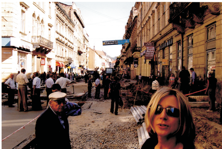
Prace modernizacyjne przy rozkopanej dawnej ulicy Sykstuskiej (obecnie ul. Doroszenki)
