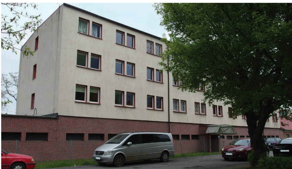
Il. 16. Budynek administracyjny „Berlin”, widok od strony południowej, główna siedziba WK PSP (fot. A. Kozaczek, 2016)
