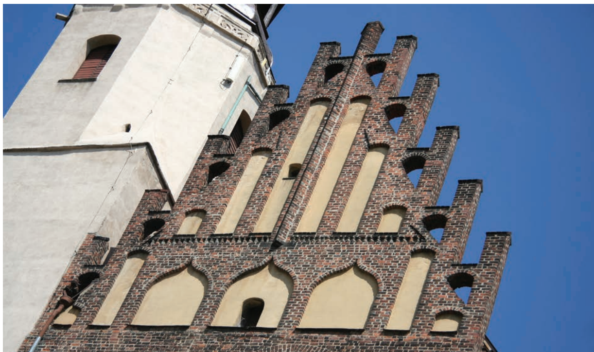
Il. 12. Dzierżoniów, kościół parafialny pw. św. Jerzego, szczyt zachodni (fot. A. Legendziewicz, 2014)
