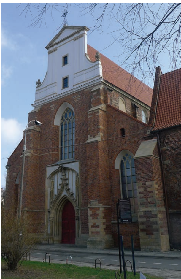
Il. 1. Wrocław, kościół pobernardyński, elewacja zachodnia – stan po remoncie w 2015 r. (fot. M. Małachowicz, 2017)
