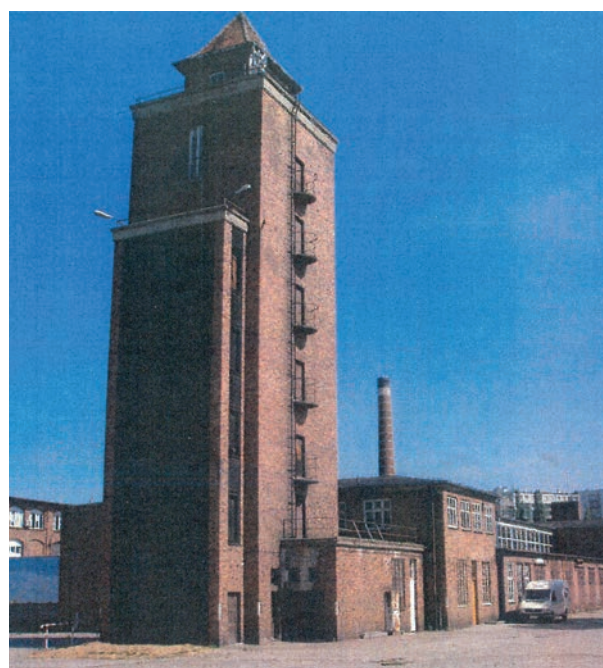
Il. 12. Hala napraw przed wyburzeniem (Archiwum Komendy Wojewódzkiej Państwowej Straży Pożarnej we Wrocławiu, 2012)
