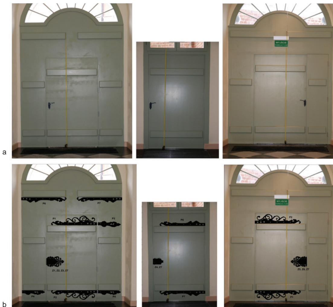
Il. 8. Wrocław, budynek dawnego Orphanotropeum (B. Paintner, 1702–1715), przykład propozycji dopełnienia pustych (a) rewersów zewnętrznych drzwi portalowych zgodnymi z epoką i rangą obiektu stylizowanymi na barokowe elementy okuć (b) (proj. R. Karnicki, 2010)
