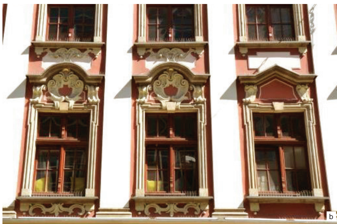
Il. 9. Budynki przy ul. św. Mikołaja 8–10, stan z 2016 r.: a) widok od strony zachodniej, b) fragment barokowej fasady domu nr 8 (fot. P. Kirschke)
