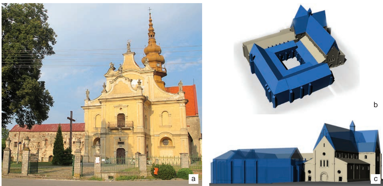
Il. 7. Opactwo w Koprzywnicy, zestawienie stanu istniejącego i prób rekonstrukcji: a – widok od zachodu (fot. P. Zwierzchowski, 2015), b, c – próba rekonstrukcji zakresu przebudów z XV/XVI w. (oprac. P. Zwierzchowski, 2016)
