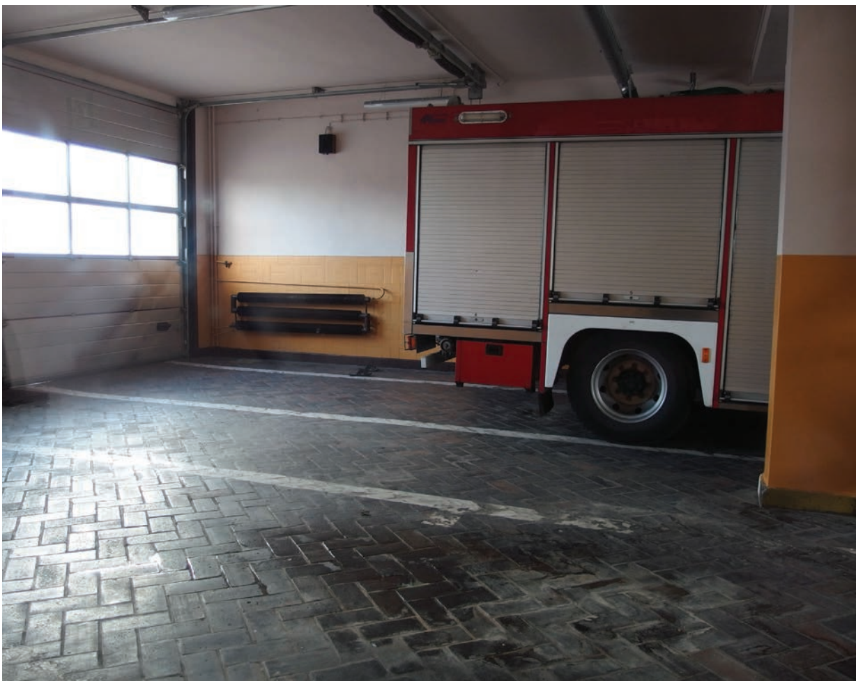
Il. 4. Wnętrze garaży w remizie, na ścianach i podłodze nadal istnieją ceramiczne płytki, częściowo pomalowane farbą olejną (fot. A. Kozaczek, 2016)
