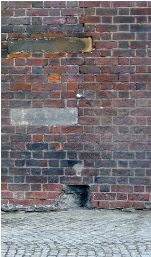
Il. 9. Wrocław, kościół pobernardyński, elewacja zachodnia – odsłonięty narożnik wielobocznego zamknięcia dawnego oratorium i wzmocnienie kamiennymi ciosami styku wbudowanych murów (fot. M. Małachowicz, 2017)
