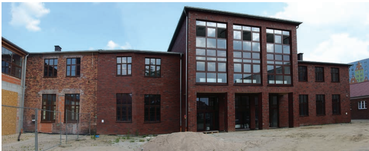
Il. 17. Budynek warsztatowni, nowe skrzydło południowo-wschodnie, widok od strony zachodniej (fot. A. Kozaczek, 2016)
