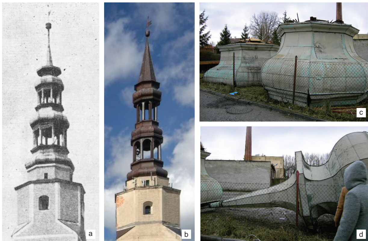
Il. 5. Wieża zamkowa w Bierutowie: a) hełm przed „konserwacją” (za: [24, il. 3]), fragment, b) stan obecny (fot. S. Milejski, 2013), c) i d) zdemontowane części hełmu, 2005 r. (fot. M. Grabiński)
