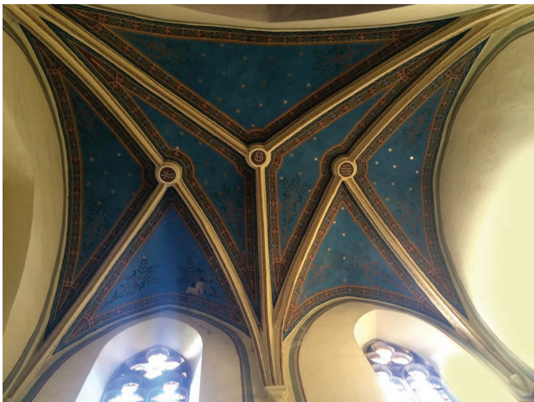
Il. 8. Dzierżoniów, kościół parafialny pw. św. Jerzego, sklepienie trójpodporowe we wschodniej kaplicy ciągu południowego (fot. A. Legendziewicz, 2016)
