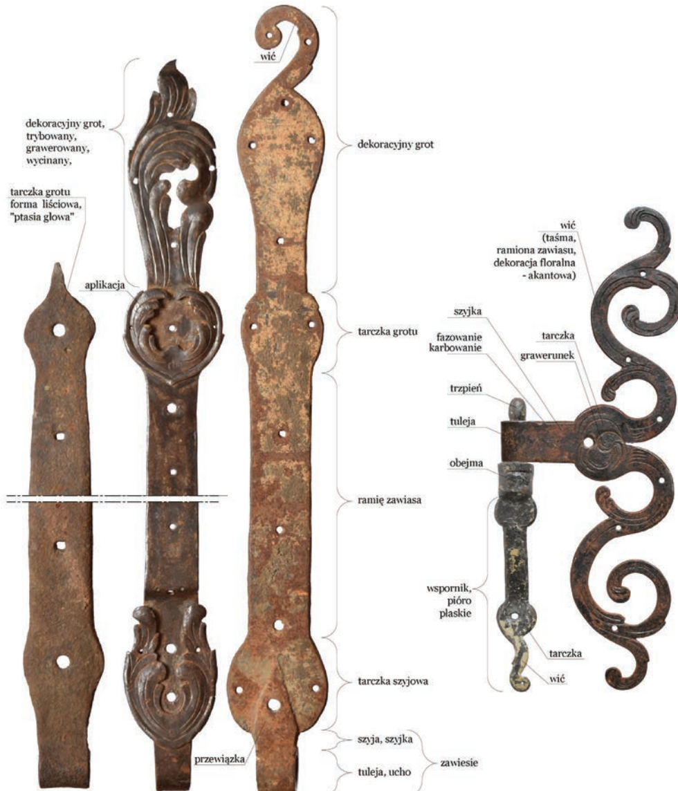
Il. 4. Przyjęte nazewnictwo elementów składowych zawiasów na przykładzie zawiasu pasowego i wiciowego (oprac. R. Karnicki)
