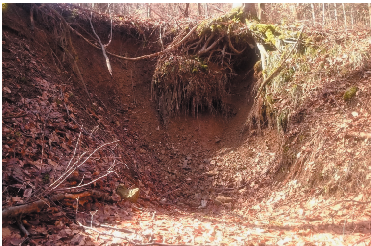
Ryc. 7. Zasypany wlot do sztolni nr 11a (fot. A. Marek), stan z dnia 2.04.2016 r. Fig. 7. Buried entrance to adit 11a (photo A. Marek), condition as for 2.04.2016
