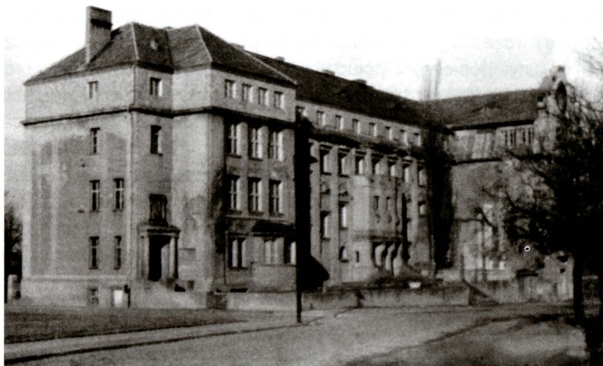
Odbudowany budynek szkoły – 1956 r.
