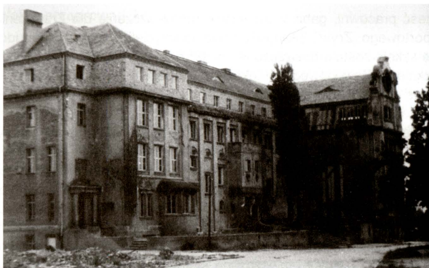
Szkoła przy Pl. Jana z Głogowa w trakcie odbudowy – lata 50.
