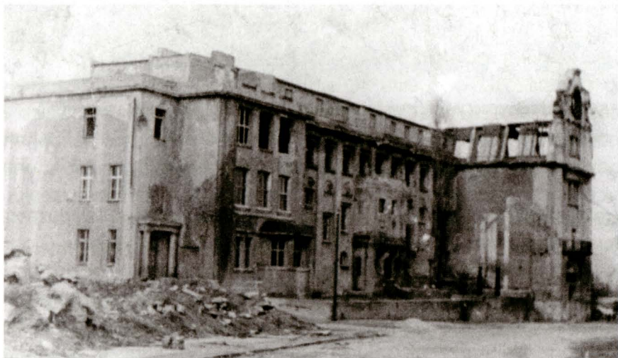
Ruina budynku szkoły w 1946 r.
