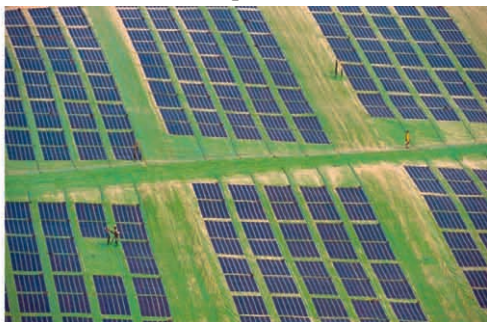
Rys. 5.1. Farma fotowoltaiczna na geomembranie pokrywającej zrehabilitowane składowisko odpadów komunalnych [www.hdrinc.com]
