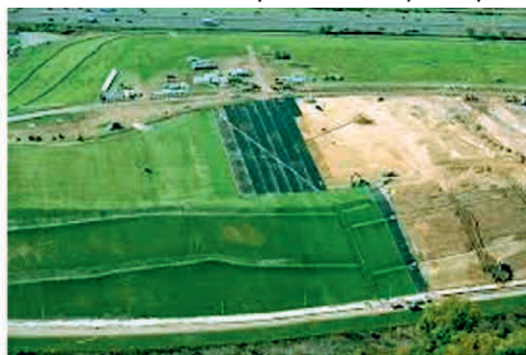
d) posadowienie paneli PV
