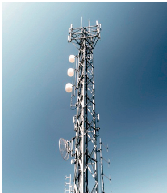
Rys. 9.5. Przykładowa stacja bazowa 4G umożliwiająca efektywną komunikację urządzeń Internetu rzeczy z zastosowaniem standardu NB-IoT
