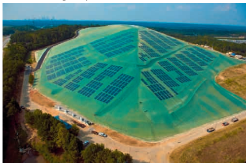
Rys. 5.1. Farma fotowoltaiczna na geomembranie pokrywającej zrehabilitowane składowisko odpadów komunalnych [www.hdrinc.com]
