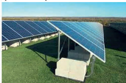
Rys. 5.2. Farma fotowoltaiczna na zrehabilitowanym składowisku odpadów komunalnych [www.watershedgeo.com]
