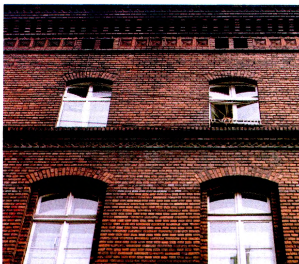
Ryc. 3. Wrocław, ul. Łaciarska 34. Stan z 1997 r. Fragment elewacji ceramicznej z kształtek i cegieł w kolorze czerwonym, dzielonej poziomymi pasami z cegieł szkliwionych na czarno
