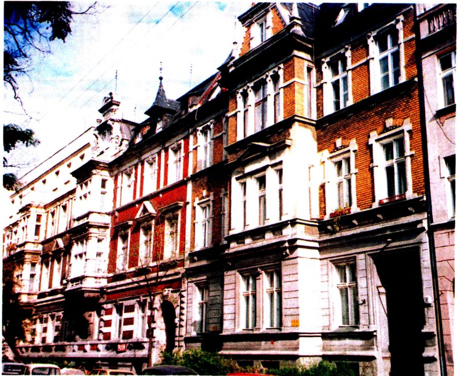
Ryc. 8. Wrocław, ul. Hercena 8, 10, 12. Stan z 1997 r. Sekwencja stojących w pierzei elewacji licowanych ceglami
