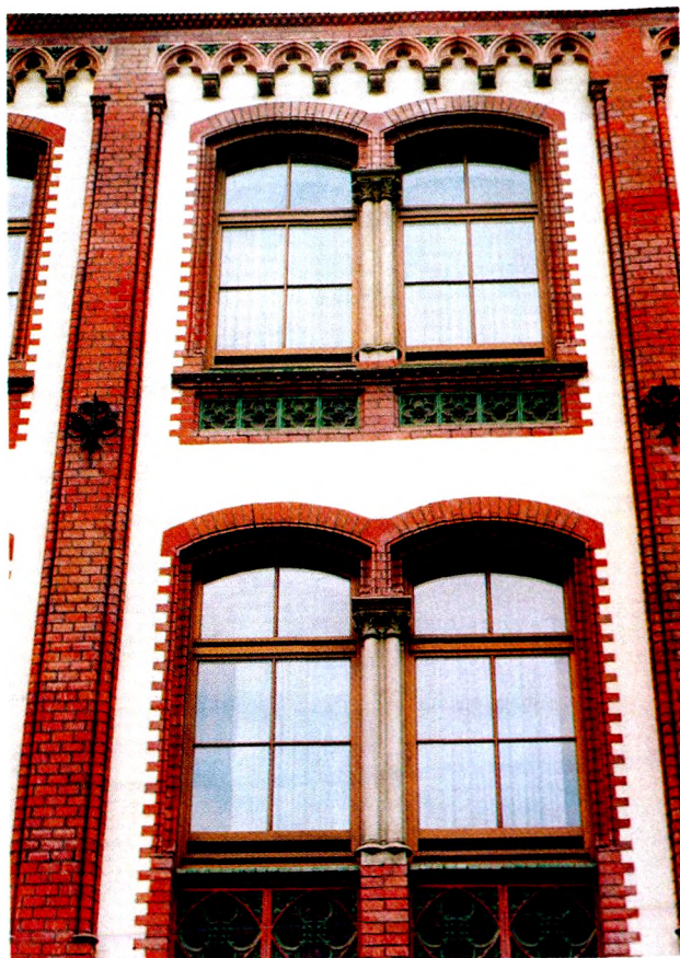
Ryc. 6. Wrocław, ul. Ofiar Oświęcimskich 19. Stan z 1997 r. Odremontowana kamienica ceglano-tynkowana z dekoracją z terakoty i kamienia
